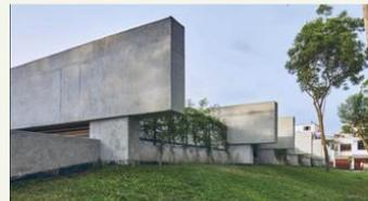
Entre vigas y como elementos de cierre, se plantean losas de hormigón con inclinaciones alternadas, un techo verde con vistas generosas a y para los edificios colindantes. El resultado es un volumen de economía constructiva, funcional y formal.
