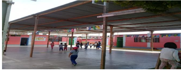
Figura 9. Vista interna del patio de la I.E. N° 1685. Área destinada a la recreación de los niños con cobertura liviana, madera y piso de cemento pulido
