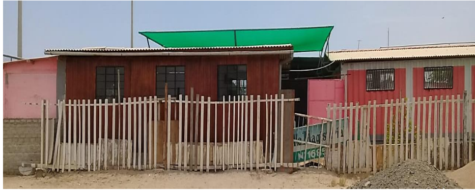
Figura 6. Vista lateral de la I.E. N° 1685 Estado actual de la Institución educativa con material precario.
