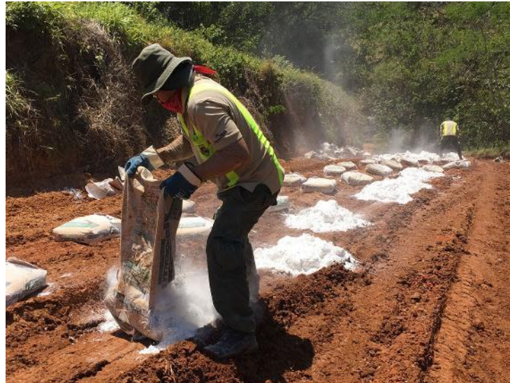
Figura 3. Estabilización de suelos
