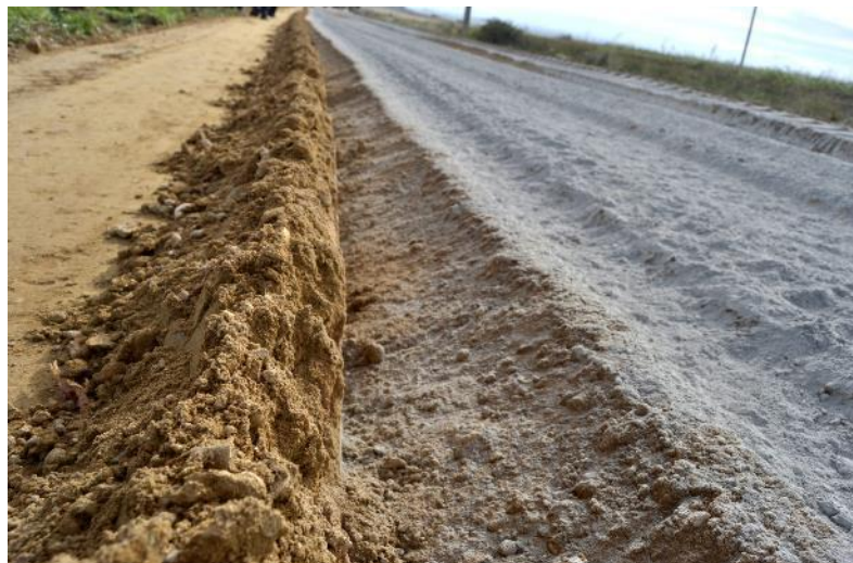
Figura 12. Estabilización de suelos con polímeros
