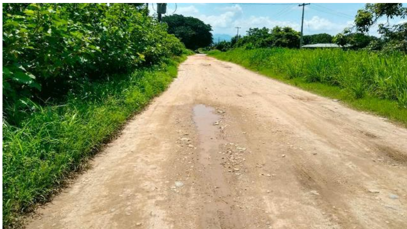
Figura 1. Vías no pavimentadas
