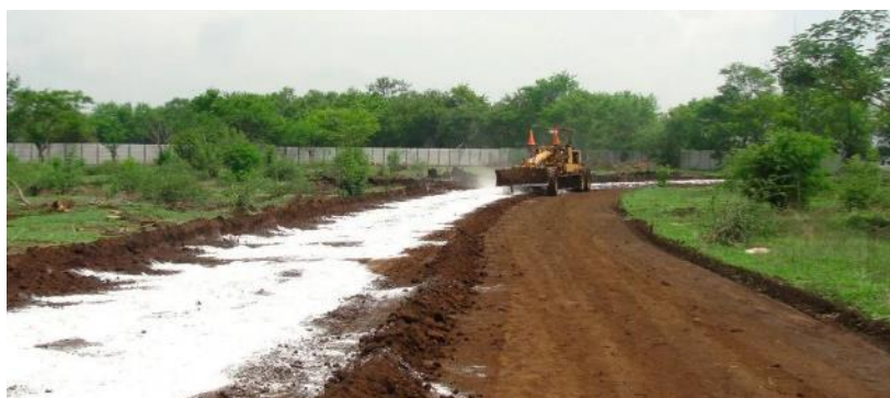
Figura 4. Estabilización con cal
