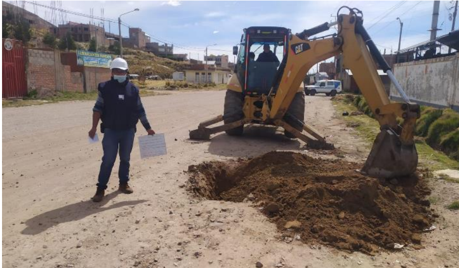
Figura 28. Tapado de calicatas de la AV. Industrial
