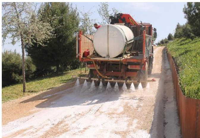
Figura 9. Polímero estabilizador de carreteras
