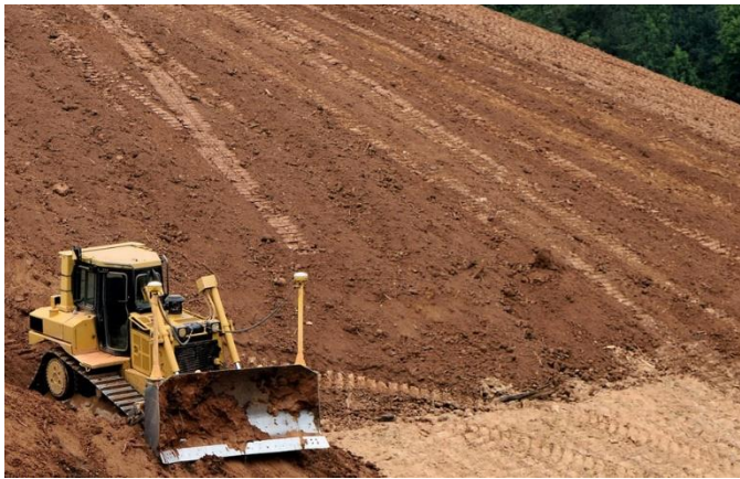
Figura 07. Estabilización de Suelos
