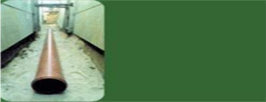
Figura 14. Construcción de Zanjas y Canales
