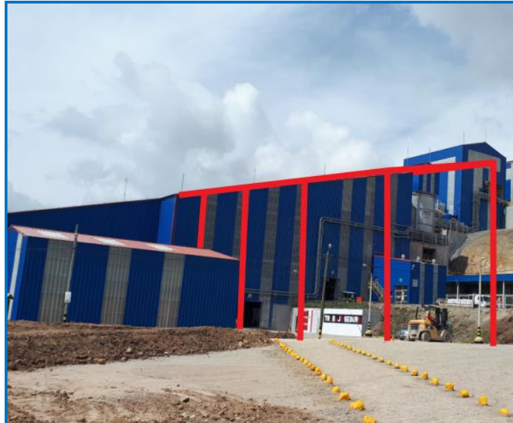
Figura N° 1 – Edificio Estructural existente y futura ampliación indicado de color rojo Fuente: Elaboración propia
