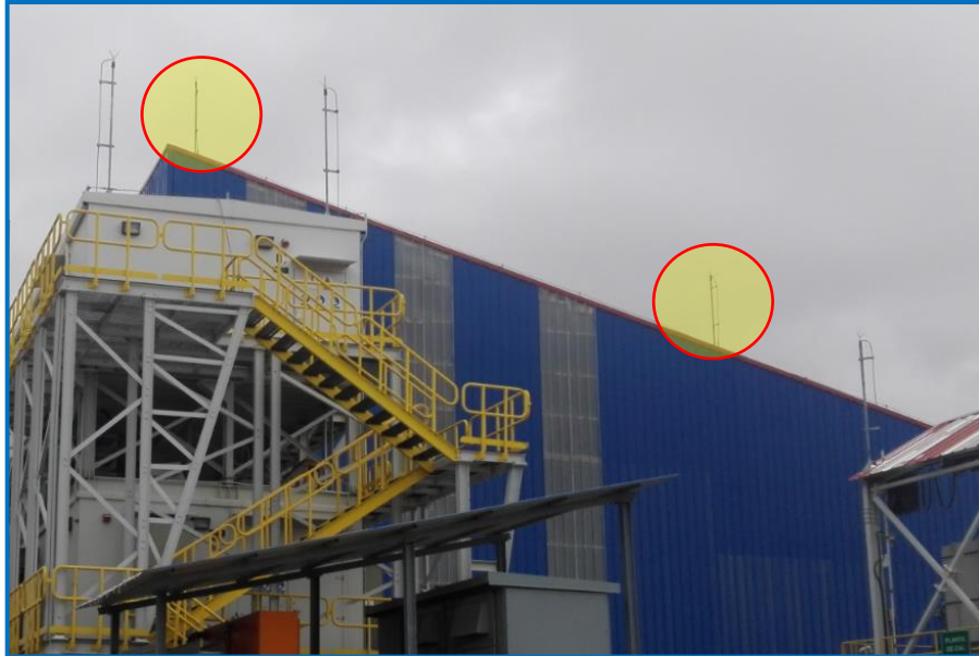
Figura N° 20 – Vista lateral derecha del edificio existente
