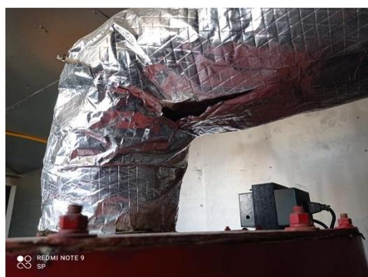
*Figura N°7: La cubierta de la salida de humos está rota.*
