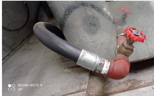
*Figura N°5: Desfogue de la maquina inoperativo por falta de información.*
