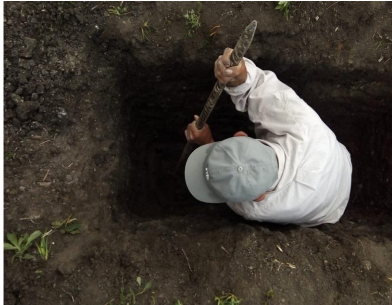
Figura N° 4: Calicata realizada en la Red de Distribución.
