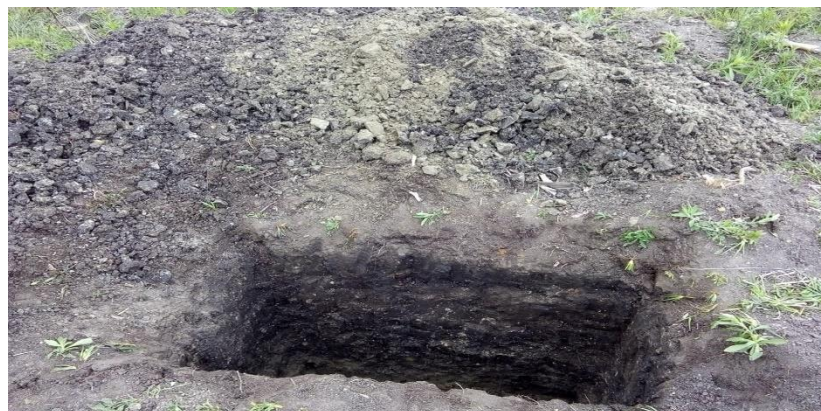
Figura N° 5: Calicata realizada en Ramal de Red de Distribución.
