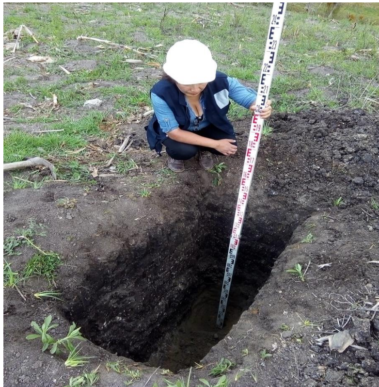
Figura N° 6: Calicata realizada en Ramal de Red de Distribución.
