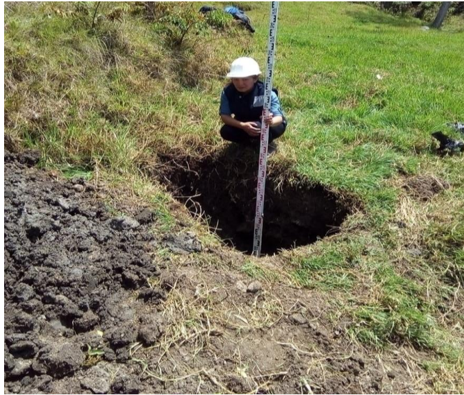
Figura N° 1: Calicata realizada en la Captación.
