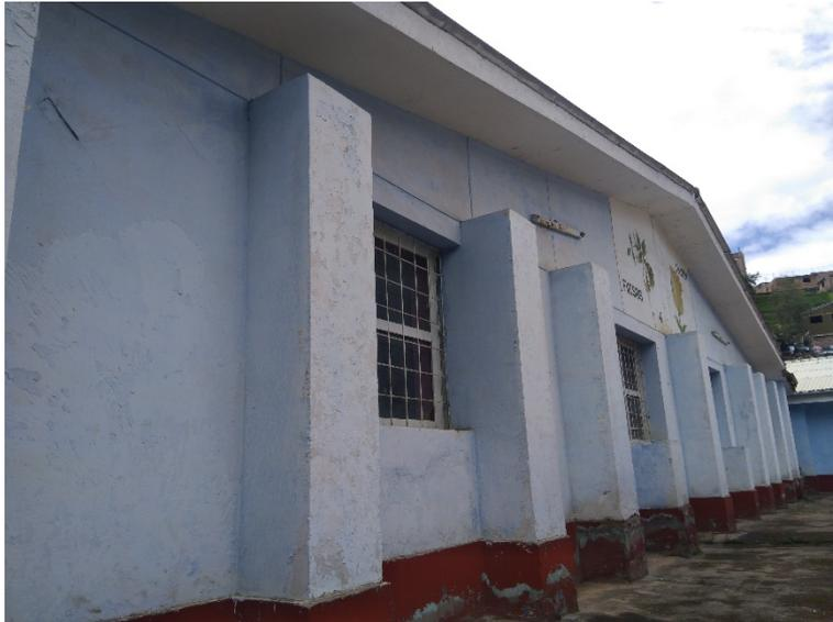
**Exterior del Bloque B – C4 – Vereda deteriorada, zócalo y pintura en mal estado.**
