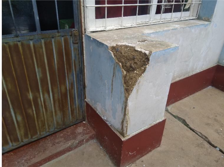
**Exterior del Bloque C – C6 – Fisura del tarrajeo del contrafuerte.**
