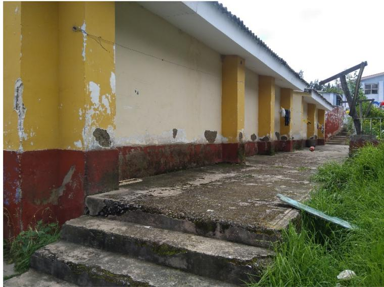
***Exterior del Bloque D – C7 – Entrada lateral completamente deteriorada por falta de mantenimiento, se aprecia la humedad por efecto del intemperismo.***
