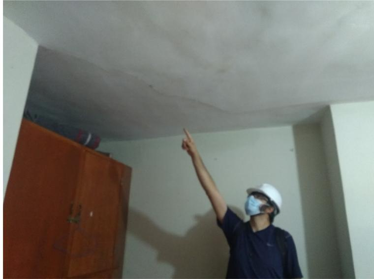
***Interior del Bloque C – C6 – Fisura en cielo raso - Detalle.***
