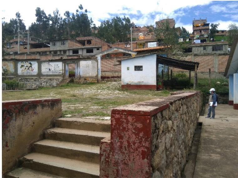
***Patio Principal – Deterioro de escaleras y veredas exteriores con presencia de humedad.***
