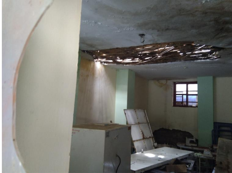
***Exterior del Bloque B – C3 – Parte de la cobertura en mal estado.***
