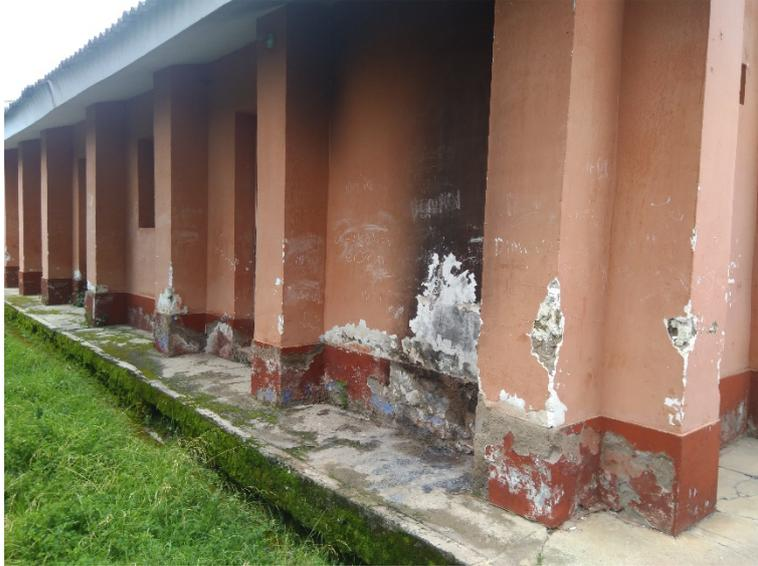
***Exterior del Bloque B – Fachada principal – Presencia de contrafuertes y zócalo exterior deteriorado.***
