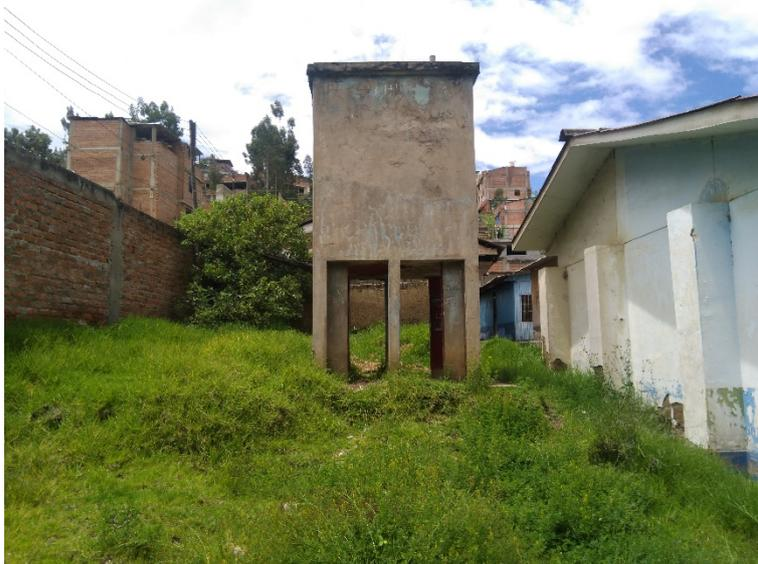
**Bloque Abandonado– Contrafuerte deteriorado por el mal estado de la tubería.**
