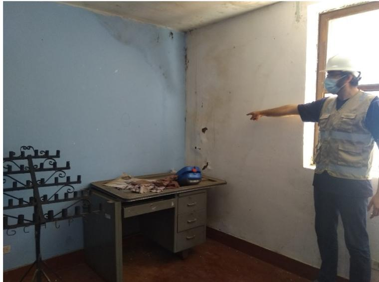
***Interior del Bloque E – Auditorio – Presencia de moho y humedad en el techo y estructura horizontal.***
