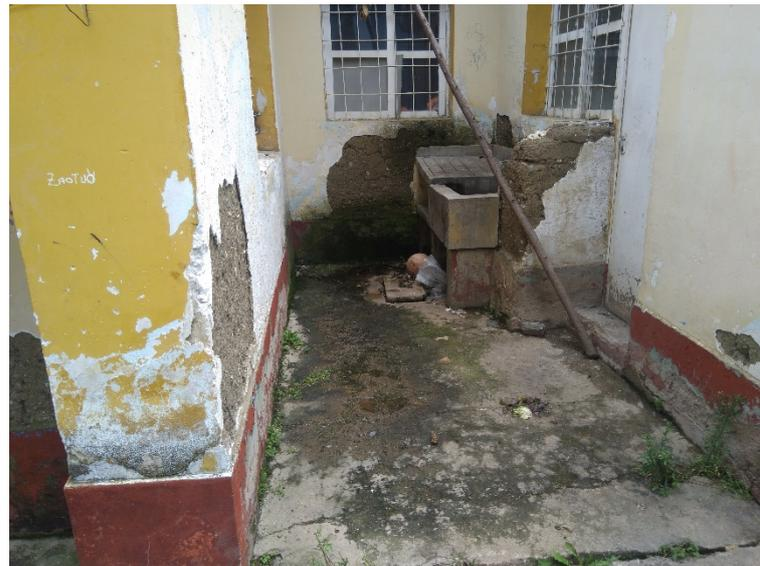
***Exterior del Bloque E – Auditorio – Fachada posterior y zócalo exterior deteriorado.***
