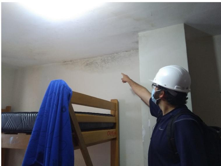
***Interior del Bloque C – C6 – Presencia de humedad en el cielo raso y muro.***
