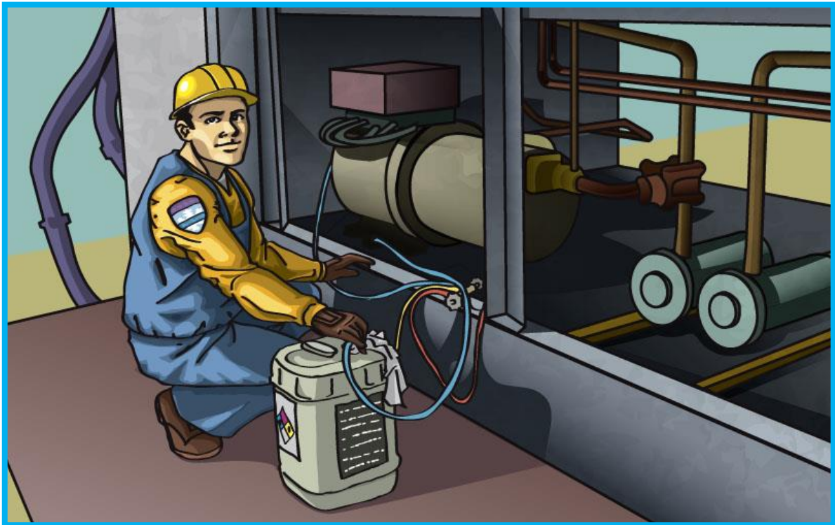
Figura 6. Limpieza de los serpentines y compresor del chillers.
