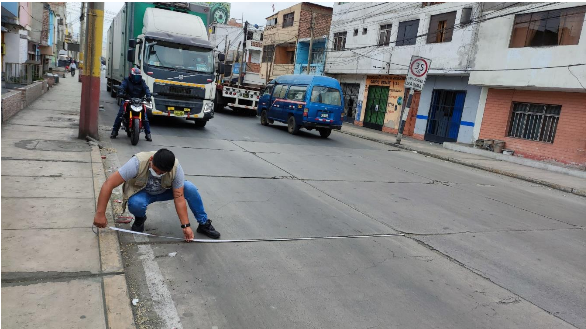
Imagen N° 06: Tomando medidas transversales del paño a evaluar del Tramo 2, Av. Aviación cuadra 3
