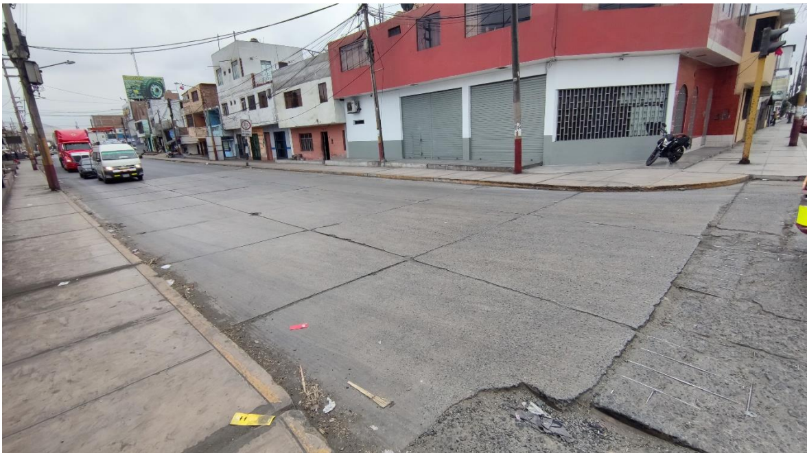
Imagen N° 04: Señalización y ubicación del Tramo 2, en la Av. Aviación Cuadra 3
