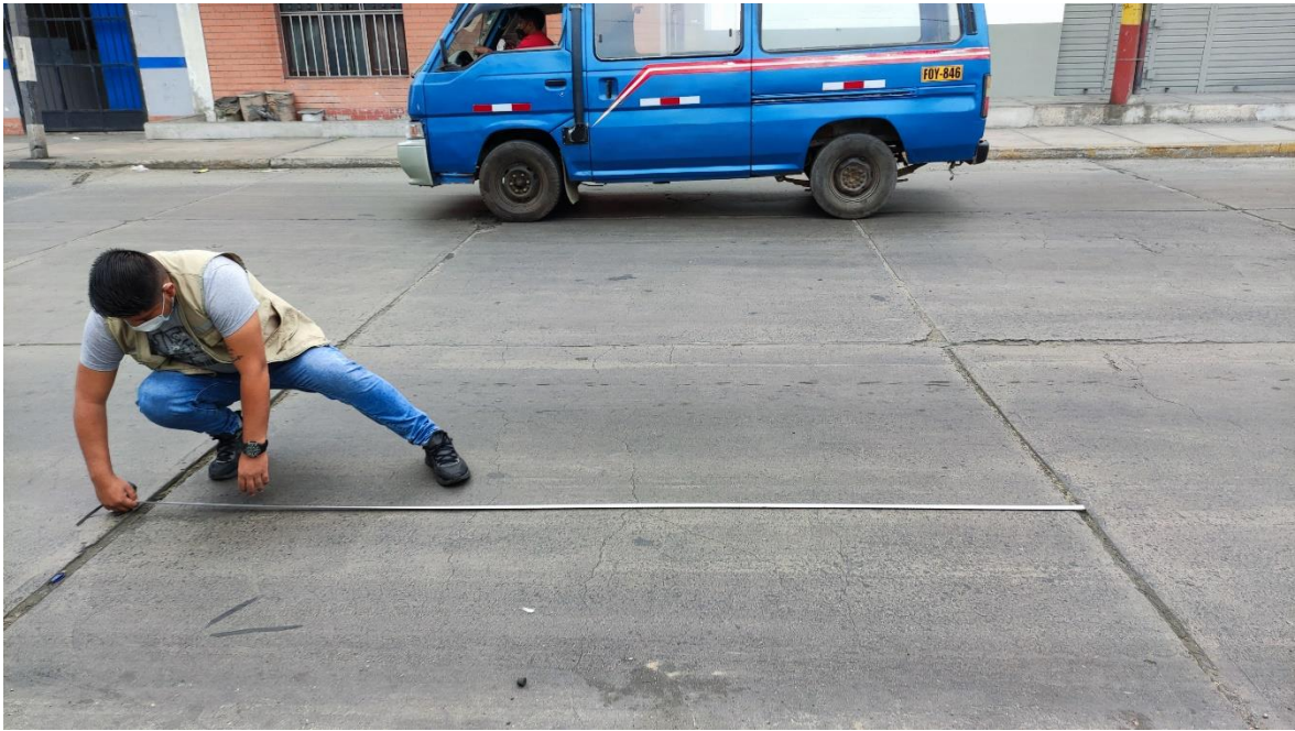
Imagen N° 05: Tomando medidas longitudinales del paño a evaluar del Tramo 2, Av. Aviación cuadra 3
