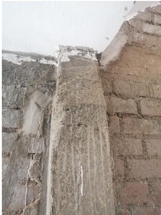
Fotografía 6. Fallas ocasionadas por la autoconstrucción
