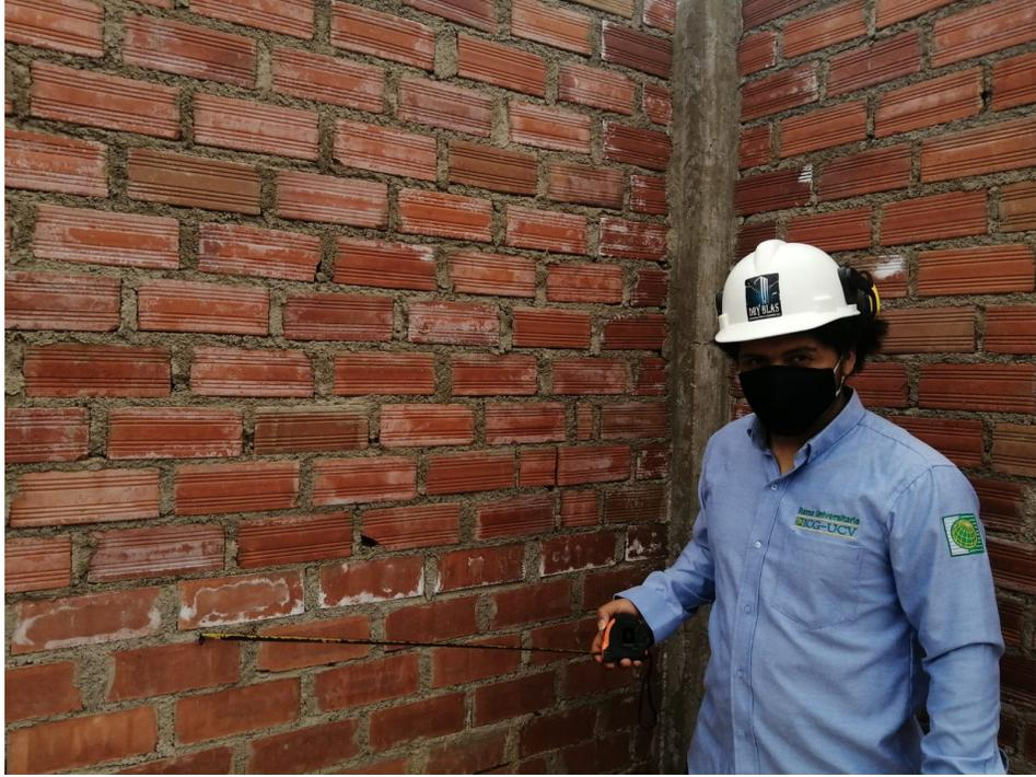
Fotografía 5. Fallas ocasionadas por la autoconstrucción
