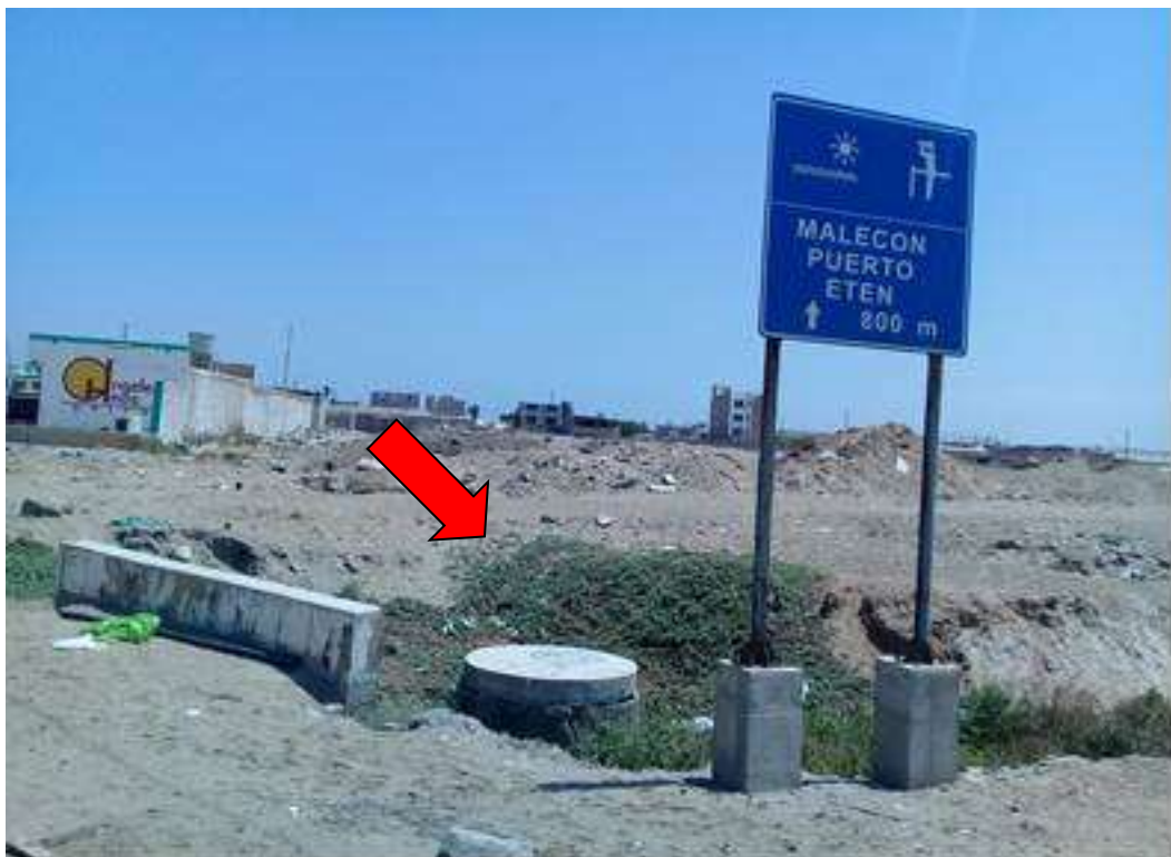
Foto N° 2: Contaminación de suelos por la ubicación de buzones en causes de los canales
