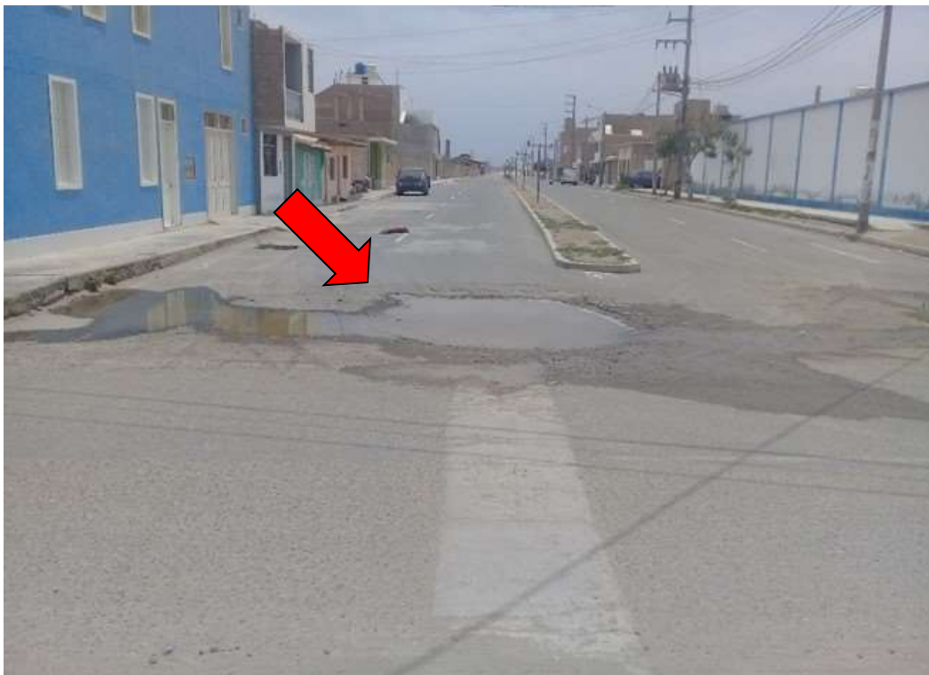
Foto N° 4: Fugas de aguas residuales en Av. Dos de Mayo y Calle Diego Ferre
