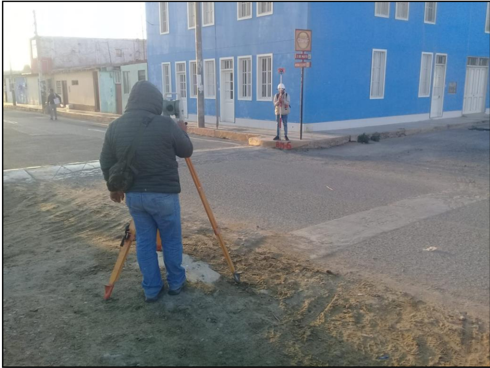
Vista del personal técnico realizando la medición correspondiente Del BM-6
