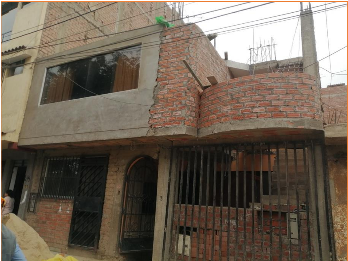
Figura 1. Vivienda existente autoconstruida 2 niveles.
