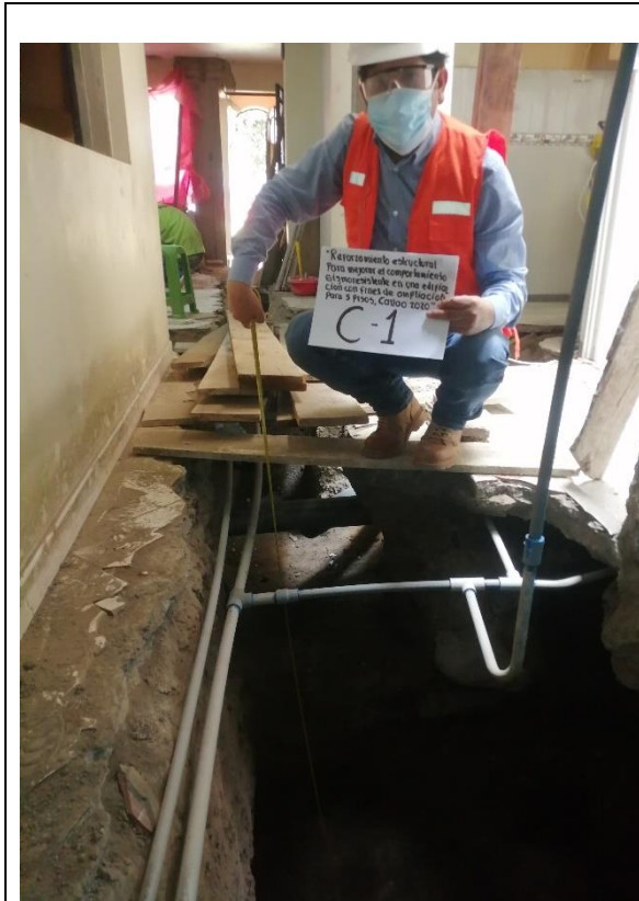
Excavación de calicata N°1
