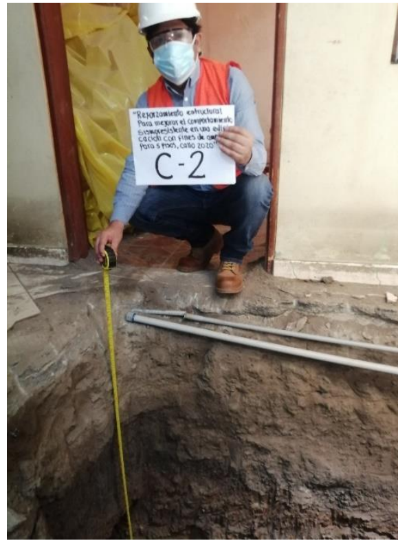
Excavación de calicata N°2
