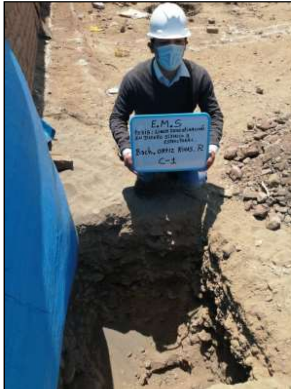
Figura N°18 Vista de la calicata – 1
