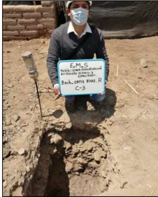
Figura N°20 Vista de la calicata – 3
