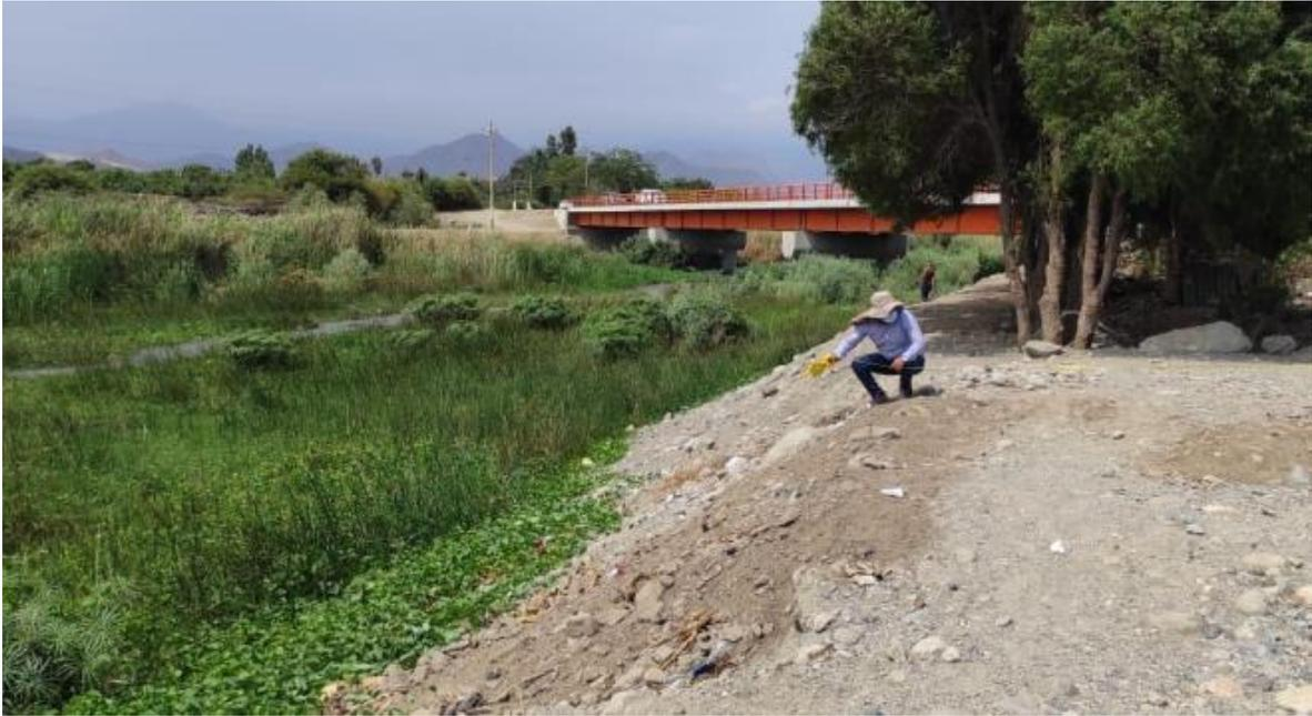
Figura 47. Ribera del río Chorobal, sector El Inca, margen derecho conformado por dique de material de préstamo compactado, se verifica cauce de río con vegetación, en la progresiva 0+450km
