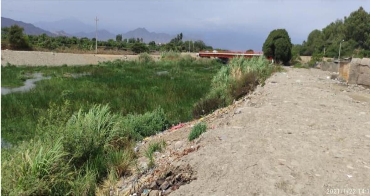
Figura 49. Ribera del río Chorobal, progresiva 0+641km, se verifico que como en todo el trayecto de estudio se observa crecida de vegetación en el cauce del río Chorobal, urgen trabajos de limpieza y descolmatacion.
