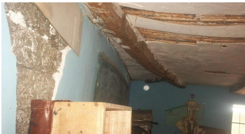
Figura 65 Vista en el interior del laboratorio de ciencias.
