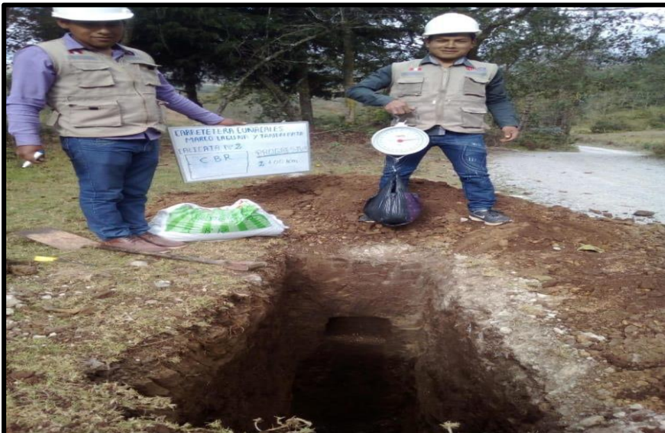
Foto N° 8. Excavación de la calicata nro. 8
