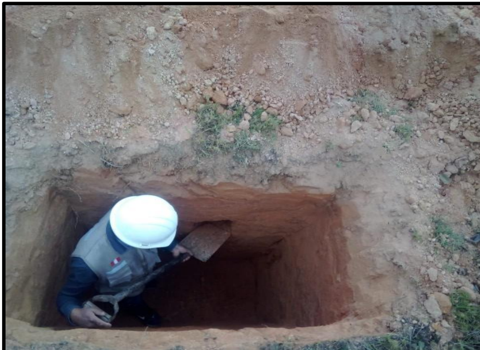
Foto N°6. Excavación de la calicata nro. 6
