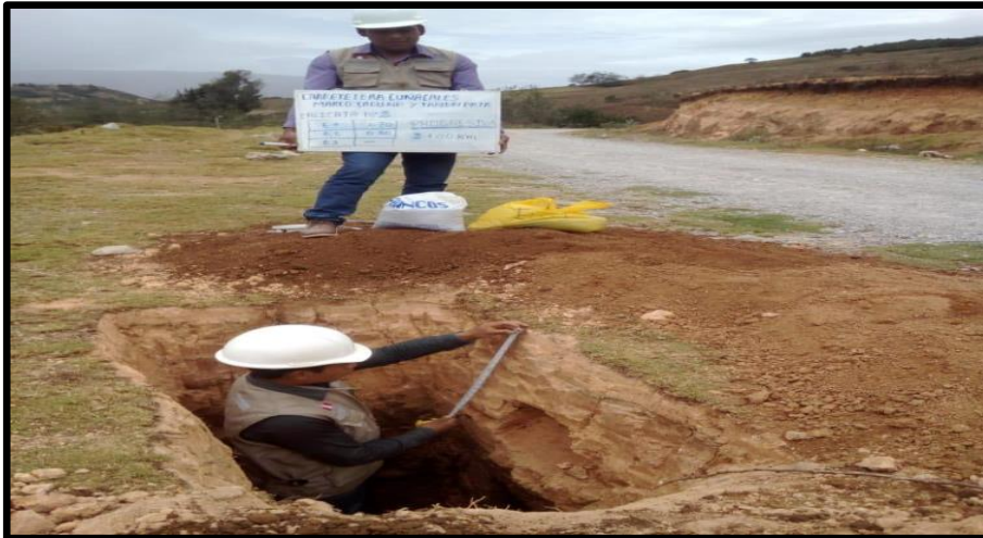
Foto N°5. Excavación de la calicata nro. 5
