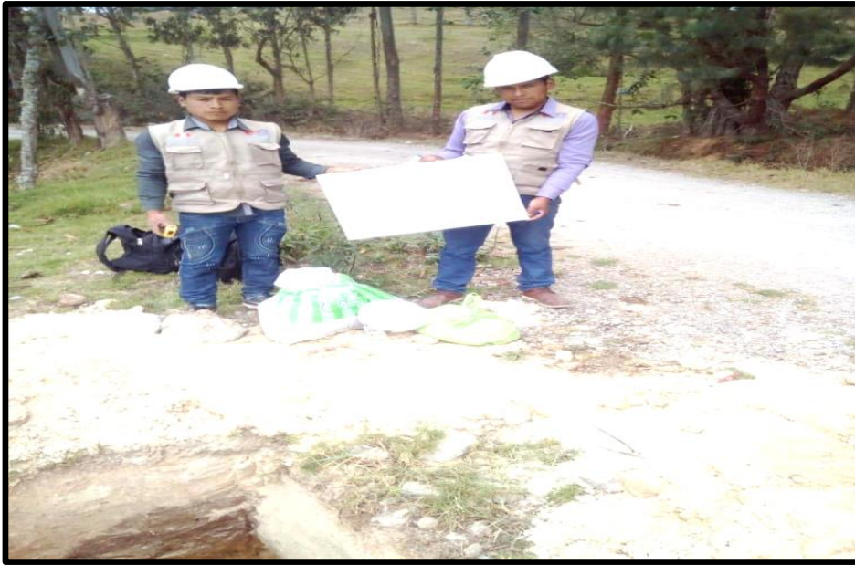
Foto N° 7. Excavación de la calicata nro. 7
