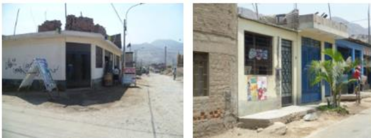
Figura 32: Viviendas del AA.HH. Enrique Montenegro, por Informe Evaluación vulnerabilidad SJL
