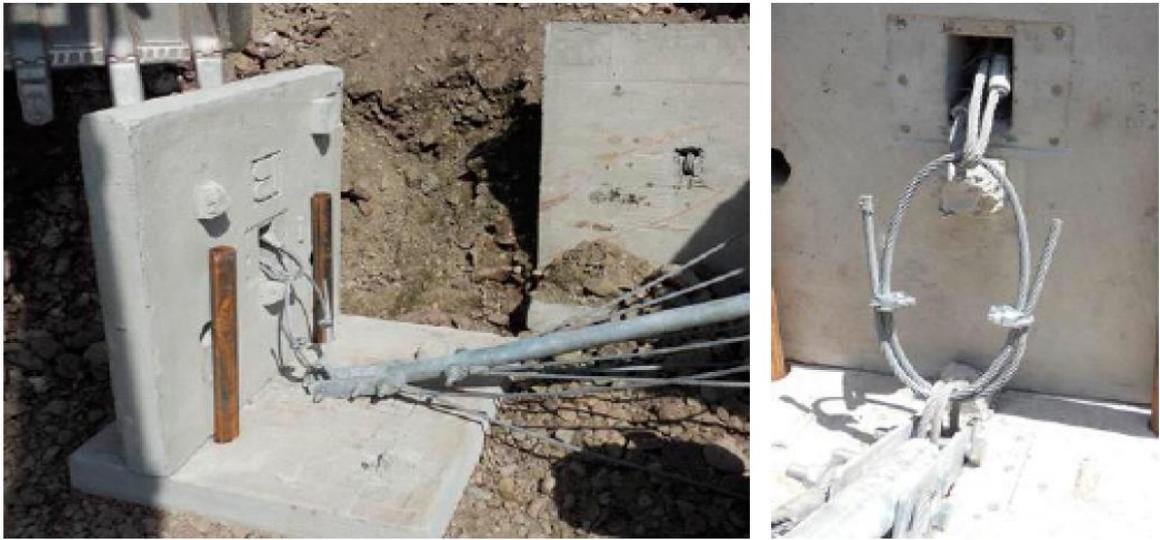
**Figura 2.** Placas de anclaje tipo L.
