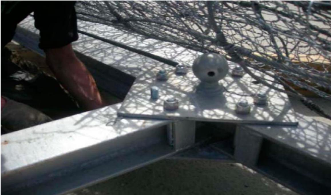
**Figura 4.** Colocación de pernos en la viga de acero.
