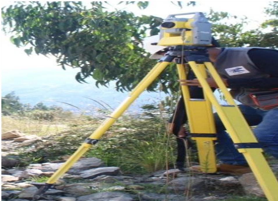
**Figura 15.** Levantamiento Planimétrico en el tramo Km 450+000 de la Carreter Huaraz – Casma
