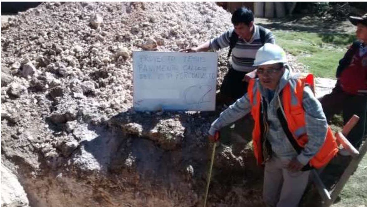
Foto 02 de Estudio de Mecánica de Suelos Calicata N° 02.
