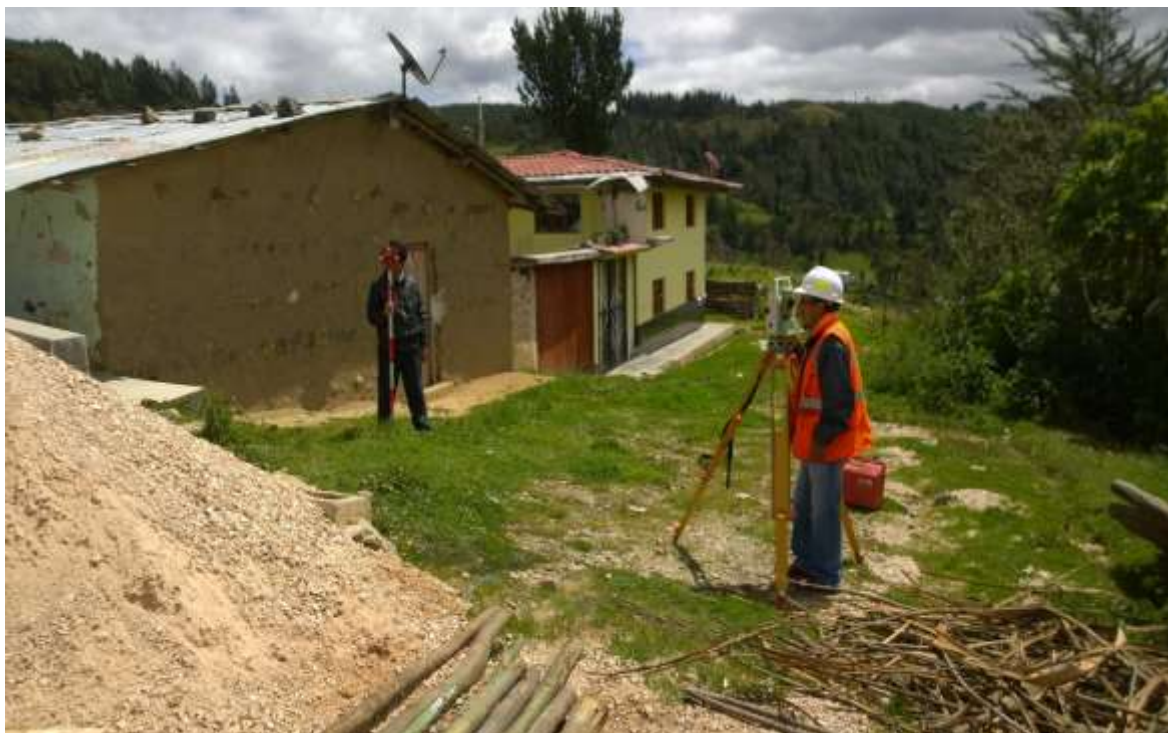
Levantamiento del Pasaje El Mirador (Vista de Jr. Cajamarca hacia el Jr. Los Quinuales)
