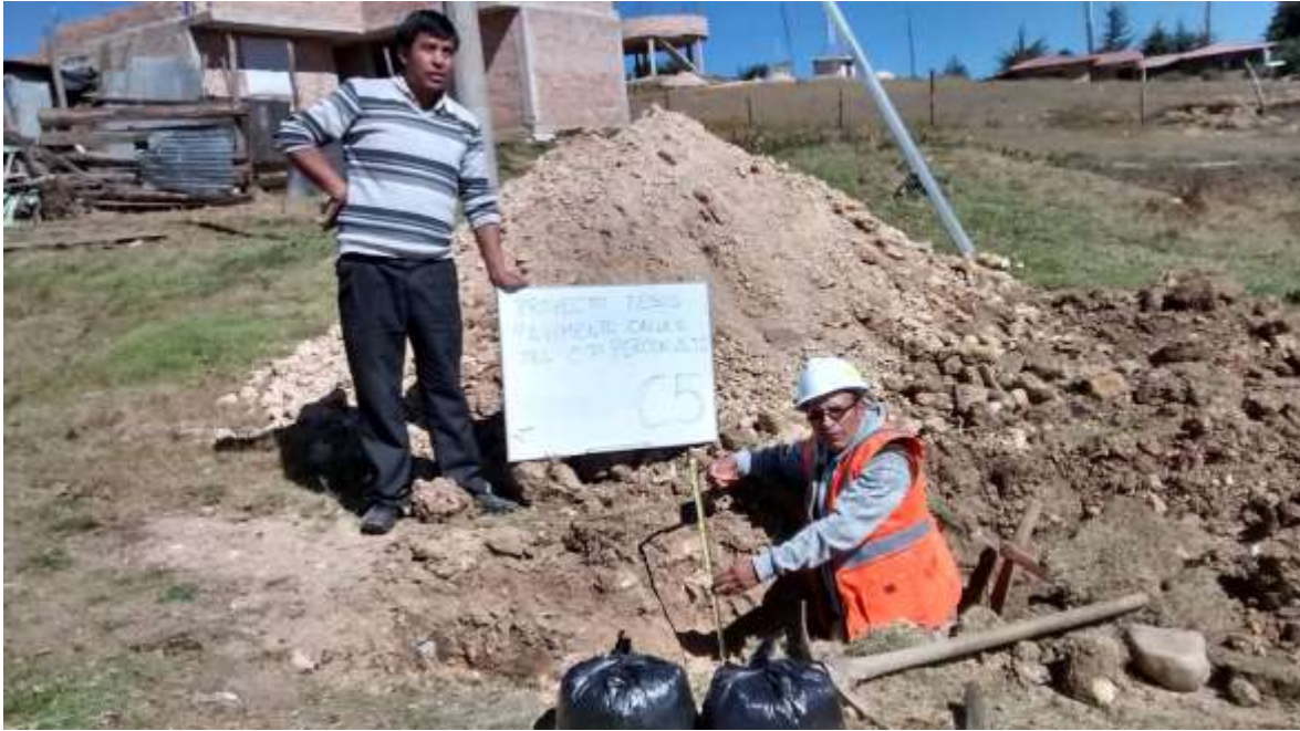
Foto 05 de Estudio de Mecánica de Suelos Calicata N° 05.
