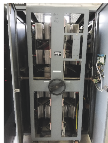
Figura 1.11b Raddrizzatore estraibile dall'armadio mediante carrello
