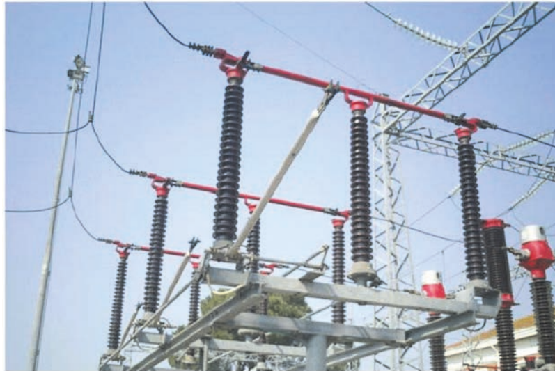
Figura 1.6 Sezionatore AT di arrivo linea
