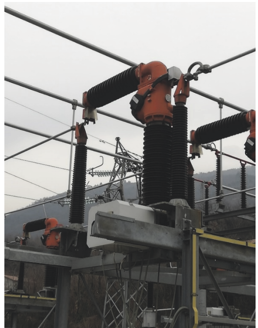
Figura 1.8 Modulo compatto stallo AT
