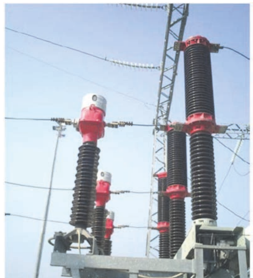
Figura 1.7 Interruttore tripolare di linea con TA incorporato
