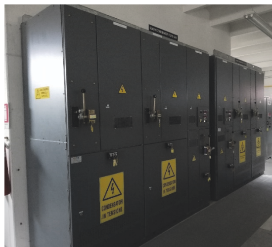
Figura 1.12 Armadi di condensatori di gruppo (A e B)
