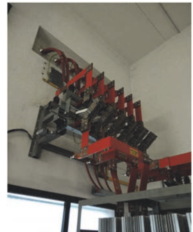
Figura 1.10 Sezionatore esapolare
