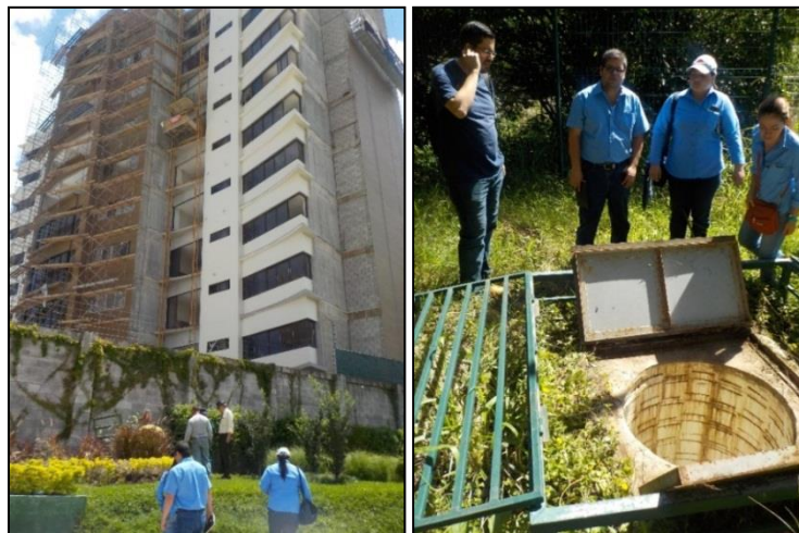
Figura 5.21. Fotografías de pozo de infiltración en proyecto Portal del Casco Fuente: Investigación piloto de infiltración de agua lluvia como dispositivo de control de escurrimiento pluvial. OPAMSS-UES (2017)
