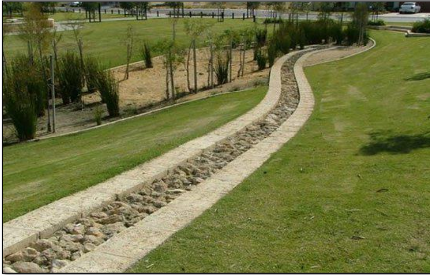
Figura 5.18. Trinchera de infiltración terminada.
