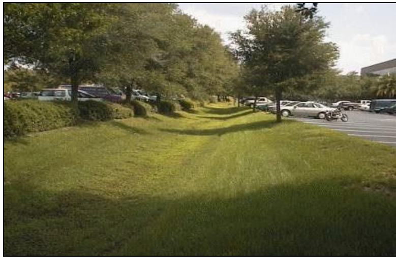
Figura 5.5. Cuneta verde seca localizada en parking asfaltado en Virginia. Fuente: Virginia DCR Stormwater Design.
