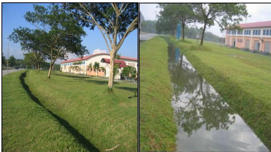
Figura 5.6. Cuneta seca antes y después de un episodio de lluvia. Fuente: River Engineering and Urban Drainage Research Centre (REDAC).
