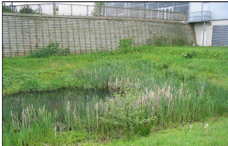
Figura 5.12. Estanque de Retención. Fuente: Sitio web drenaje sostenible (SUD)
