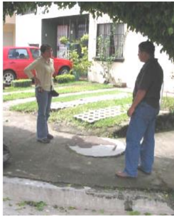
Figura 5.20. Fotografía tapa de acceso de un pozo de infiltración en la region del AMSS Fuente: Dispositivos de regulación y control del drenaje pluvial urbano. Bertoni (2005)
