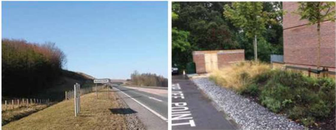
Figura 5.41. Imágenes de trincheras de infiltración.
