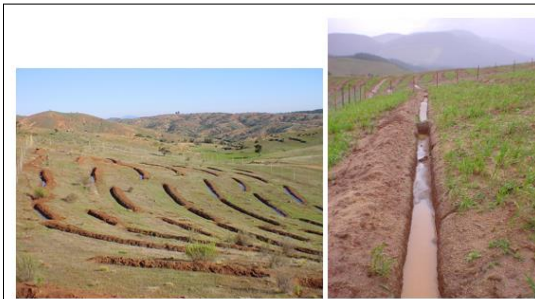
Figura 5.4. Zanjales de infiltración para recarga de acuíferos en Chile. Fuente: Centro Tecnológico de Hidrología Ambiental.
