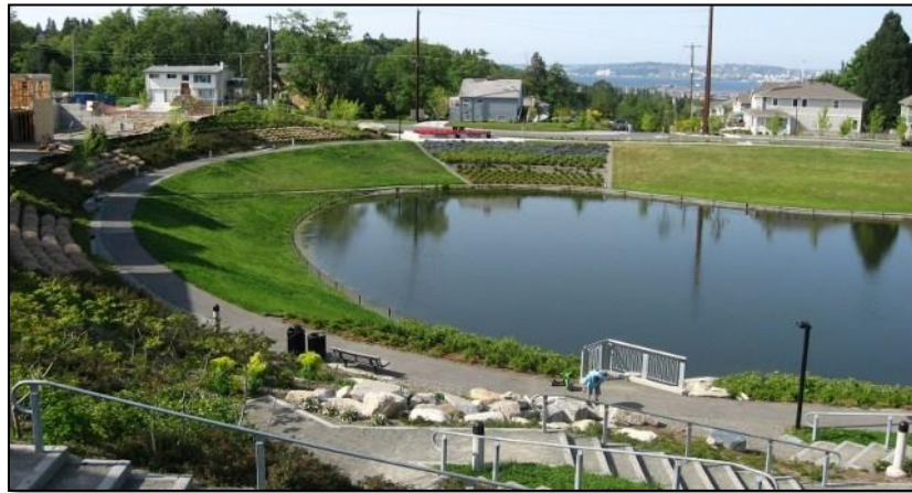
Figura 5.11. Ejemplo de Laguna de infiltración.
