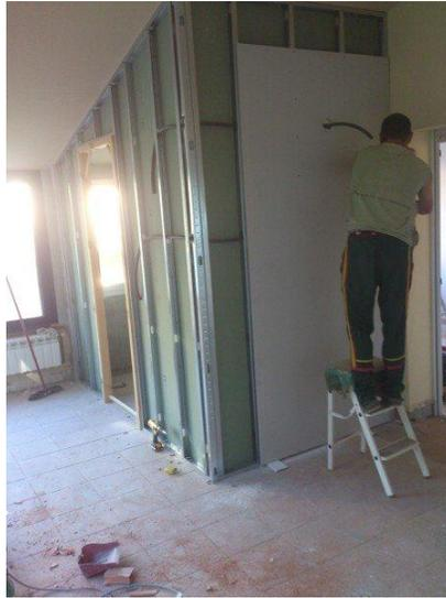
**Figura.24** Imagen Construcción con Tablaroca
