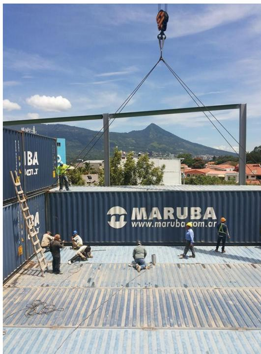
**Figura.8** proceso de montaje de contenedores sobre estructura metálica, (Estructumetal SA de CV, 2014)
