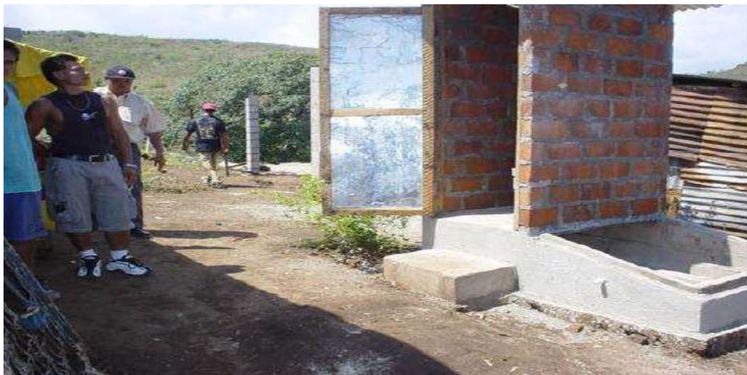
Imagen 4.6.10. Vista de la cámara solar de Letrina Solar. Fuente: Ministerio de Salud Pública y Asistencia Social, Unidad de Atención Integral al Ambiente.
