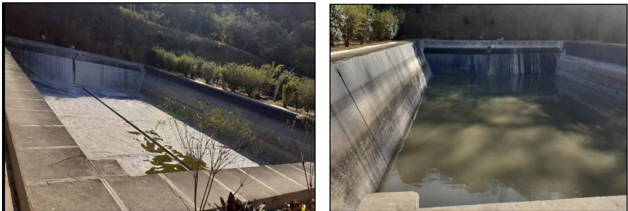
Figura 2.8 Lagunas de oxidación.
