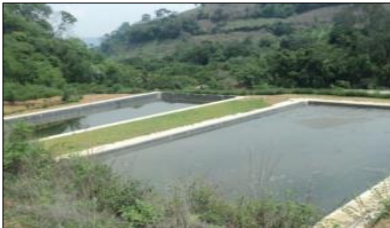
Figura 2.4 Lagunas de oxidación de PTAR del Municipio de San Lorenzo
