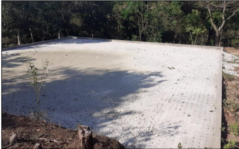
Figura 2.10 Patio de secado de lodos.
