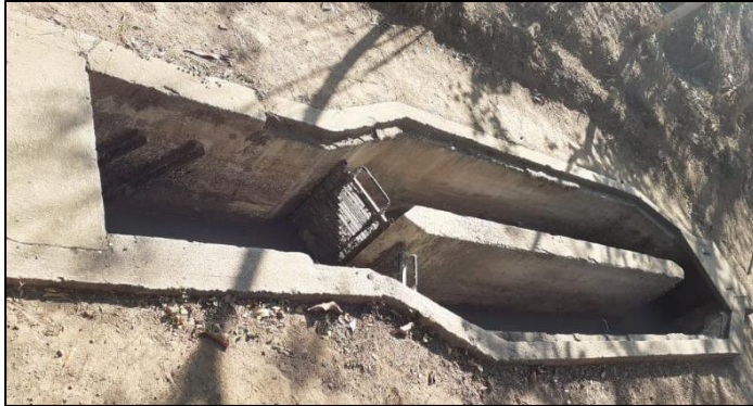
Figura 2.6 Rejillas y desarenado.
