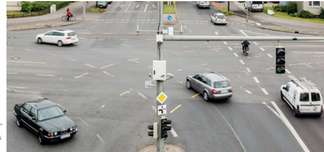
Die DLR-Forschungskreuzung in Braunschweig. Verschiedene Sensorsysteme erfassen die Verkehrssituation, um das Verhalten von Verkehrsteilnehmern besser verstehen zu können.
