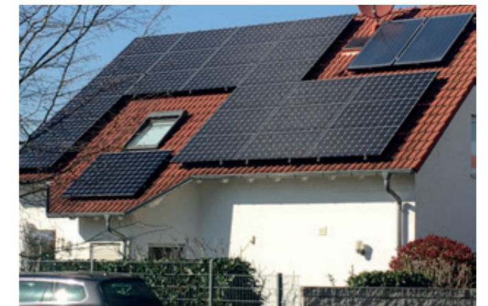
Bei der automatisierten Detektion von Solaranlagen muss die Software verschiedene Elemente unterscheiden können, um Fehlklassifikationen zu vermeiden. Solche Dächer dienen zu Testzwecken. Hier sind sowohl Solarthermie- als auch Photovoltaikmodule zu sehen, aber auch ein Dachfenster, das nicht fälschlicherweise als Solaranlage gekennzeichnet werden darf.
