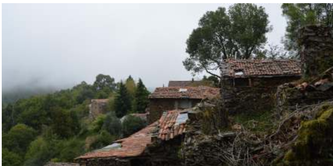
Fig. 58 - Claraboias nos telhados inclinados na aldeia do Catarredor. Autor das fotografias: Júlio Oliveira
