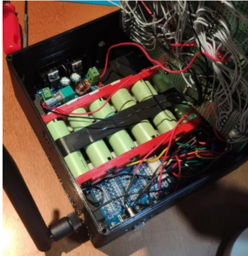
Figura 71. Montagem da bateria com a BMS no chassi do recetor e o conversor buck XHM401
