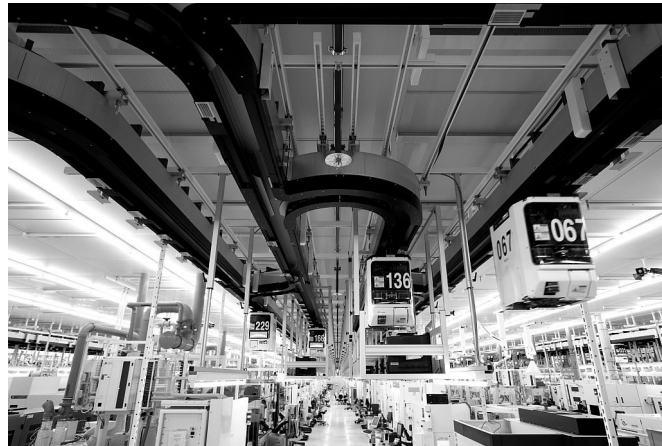
Abb. 2: OHT-Fahrzeuge (nummeriert) an Schienen (dunkel) in einer Fab (Bild: GlobalFoundries)
