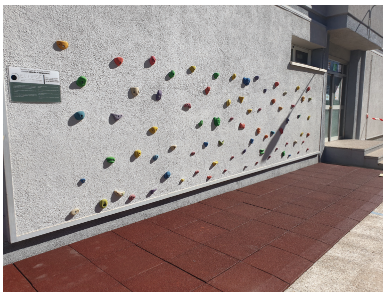
Figura 3. Rocódromo y aprovechamiento vertical del espacio del patio
