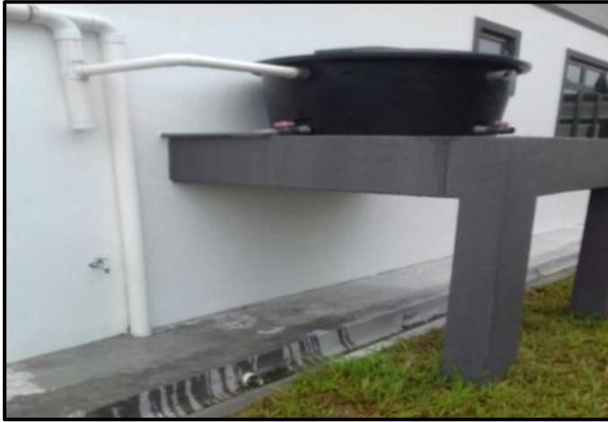
Rajah 2 : Penempatan tangki SPAH di kawasan kediaman
