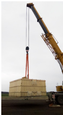
Рис. 1. Выгрузка генератора (предоставлено авторами).
