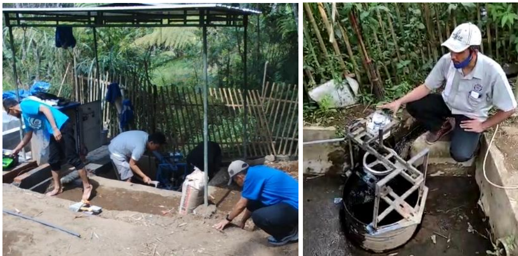
Gambar 1 Pembangunan dan pemasangan pembangkit listrik tenaga piko hidro di Kawasan JLC Kota Batu
