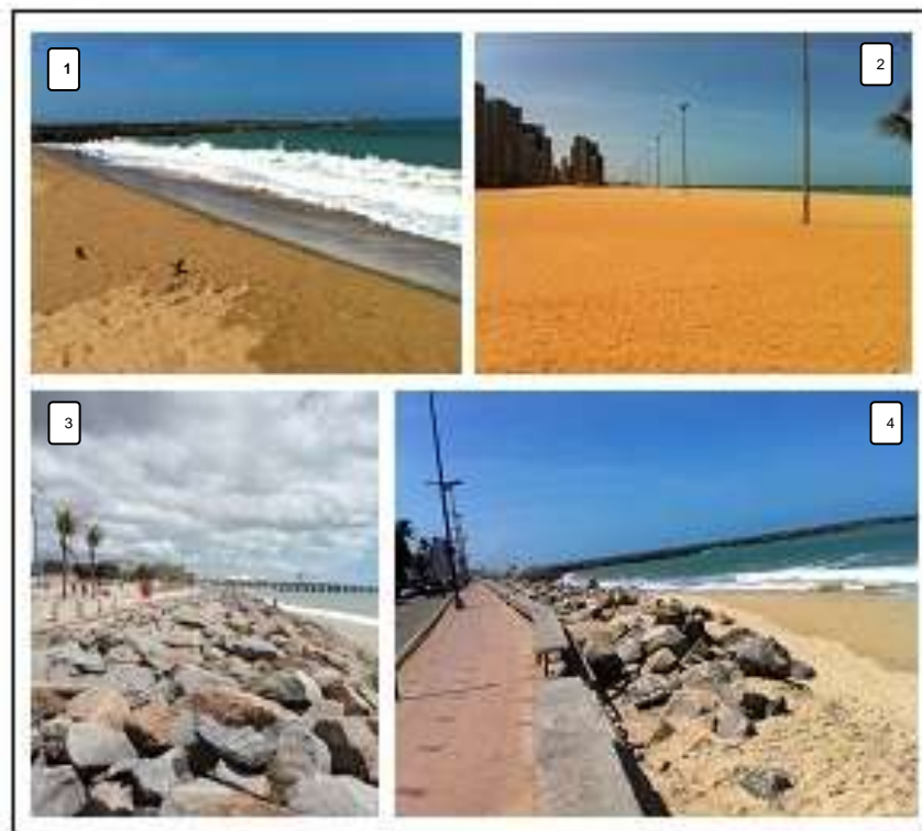
Figura 2: (1) Espigão, (2) Aterro e (3) Enrocamento na Praia de Iracema. (4) Rochas dispostas para contenção do avanço marítimo na Av. Beira Mar. Fonte: Barra (2012).
