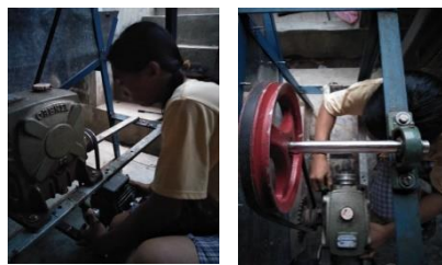
Gambar 15. Pemasangan gear box motor listrik
