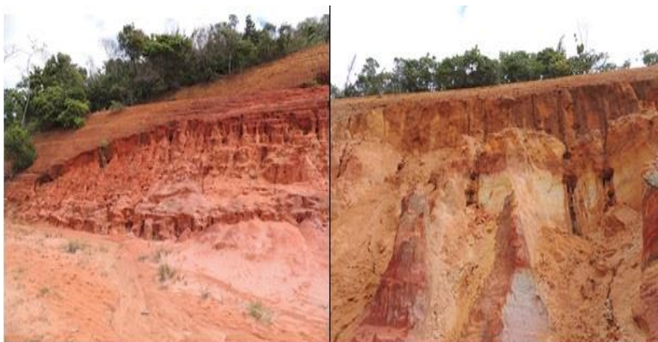
Figura 1 – Presença de cunha de ruptura. Fonte: Ailana da S. Mendes, 2017.
