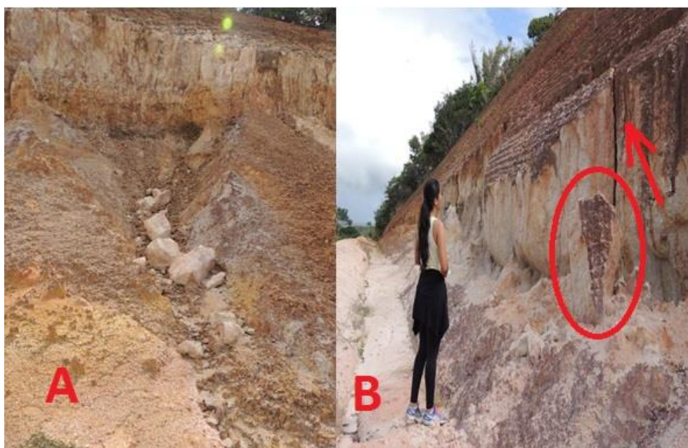
Figura 2(a) e (b) – Blocos caídos e na iminência de tombamento. Fonte: Ailana da S. Mendes, 2017.
