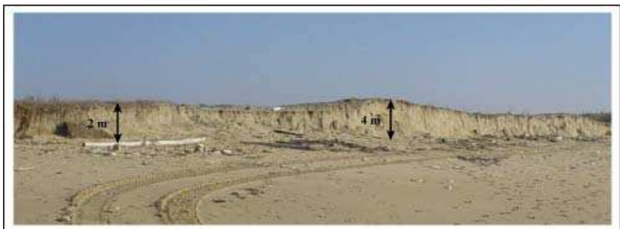
Figure 81 : Erosion observée en dehors de la zone aménagée (Vert-Bois, 25/02/2003)
