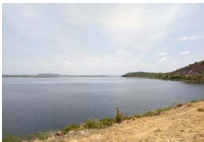
Figura 11. Situação do açude Poço da Cruz em dezembro de 2020, a montante da comunidade Poço da Cruz, município de Ibimirim – PE
