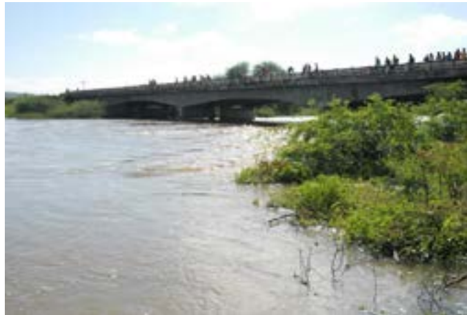
Figura 5: Registro da enchente sobre a ponte do rio Moxotó, em Ibimirim – PE, no ano de 2004
