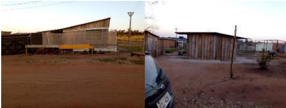
Figura 2: Casas construídas em madeira para abrigar famílias no Nova Canaã.
