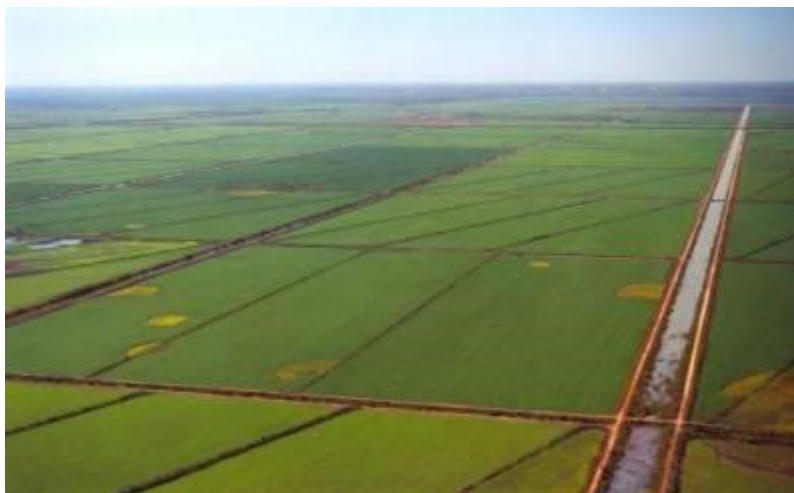
FIGURA 6 – Extensos canais de captura das águas do rio Formoso na área de irrigação, Formoso do Araguaia.
