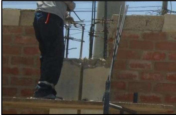
Figura N° 16. Verificación de dimensiones y acero de refuerzo en columna existente
