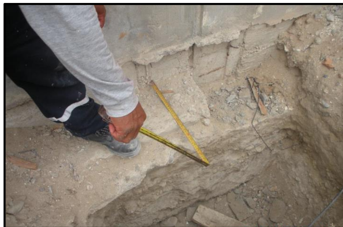
Figura N° 13. Verificación del ancho de cimentación, 0.35 m. a cada lado
