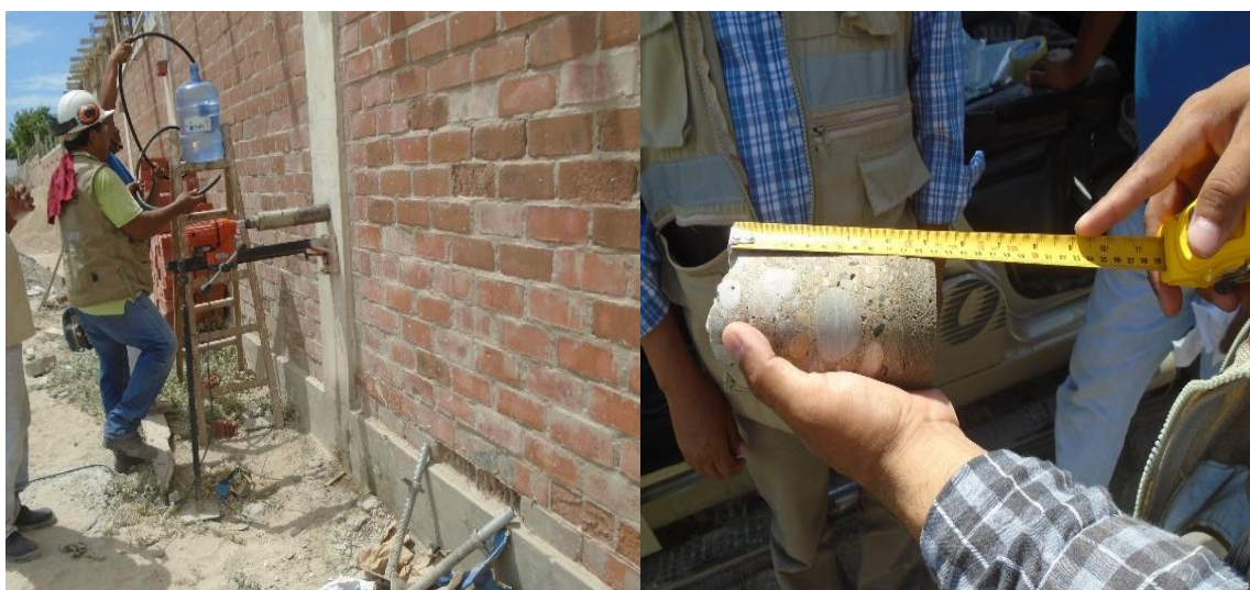
Figura N° 21. Muestra N° 01, columna existente en calle Restauración
