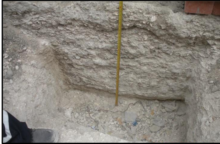
Figura N° 14. Verificación de la profundidad de cimentación 0.80 m.
