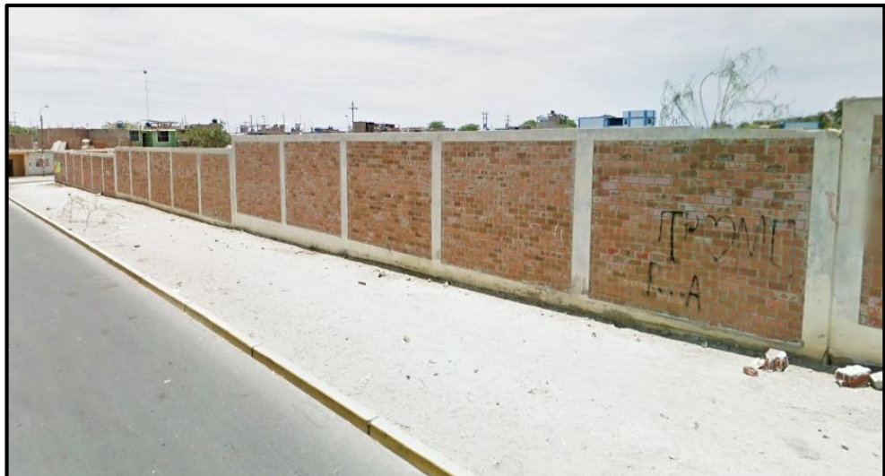
Figura N° 11. Vista del cerco perimétrico existente
