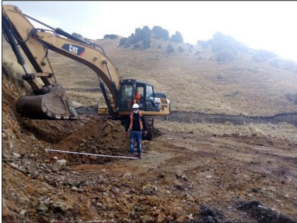
Fotografía 1. Extracción de muestra de la progresiva 3+000.
