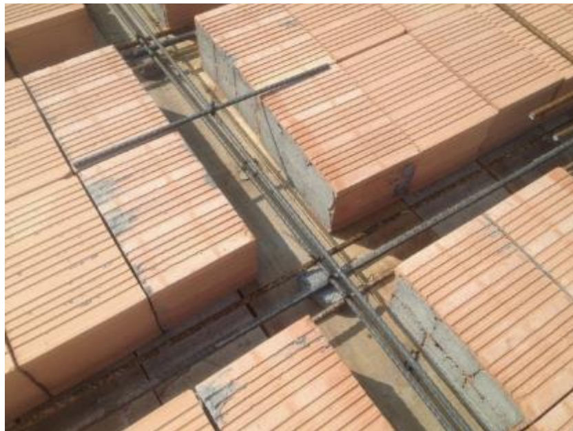
Figura 42: Losa convencional con ladrillos
