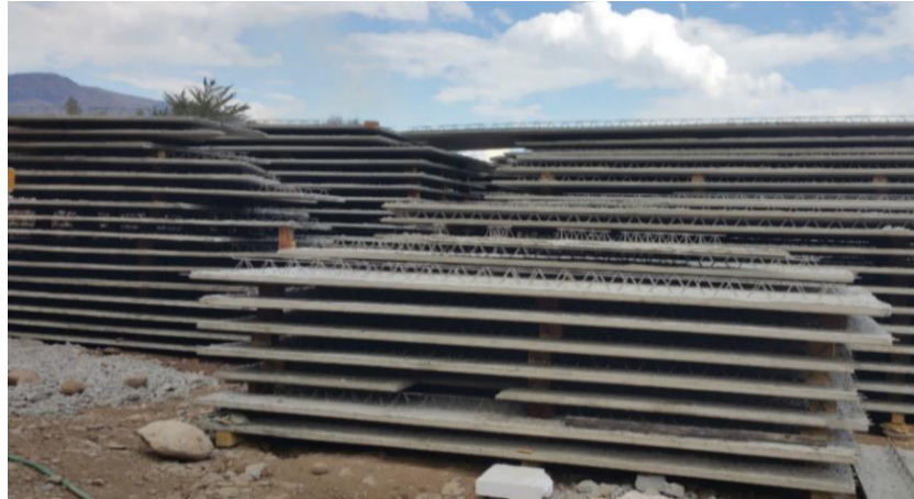
Figura 11: Apilado de prelosa
