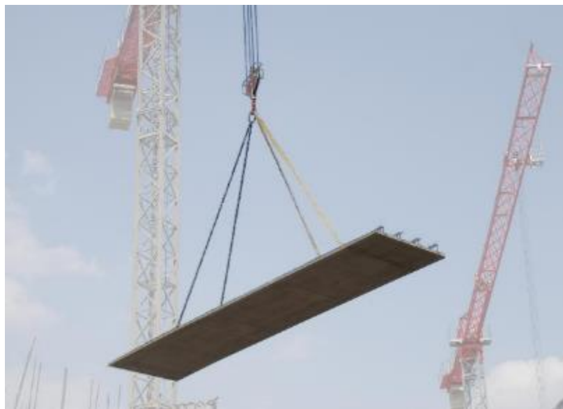
Figura 37: Colocación de prelosa sin vigüeta de izaje
