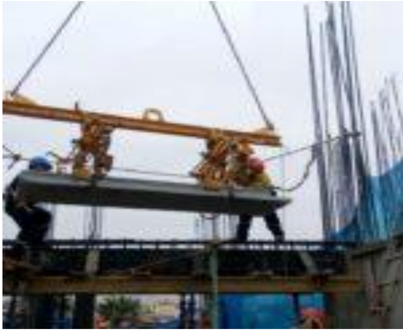
Figura 36: Colocación de prelosa con vigüeta de izaje
