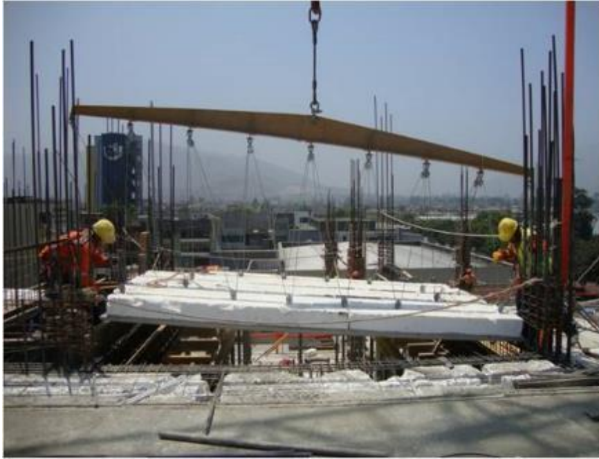
Figura 30: Instalación de prelosas
