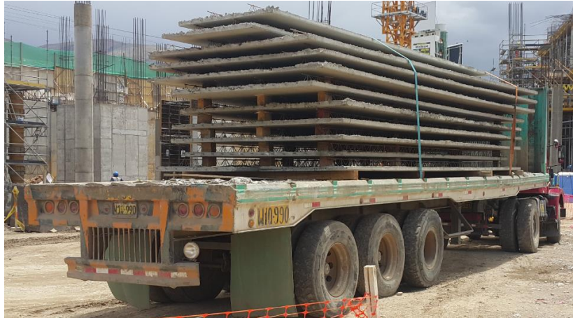
Figura 13: Cargado de prelosa
