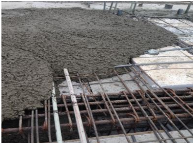
Figura 31: Llenado de concreto
