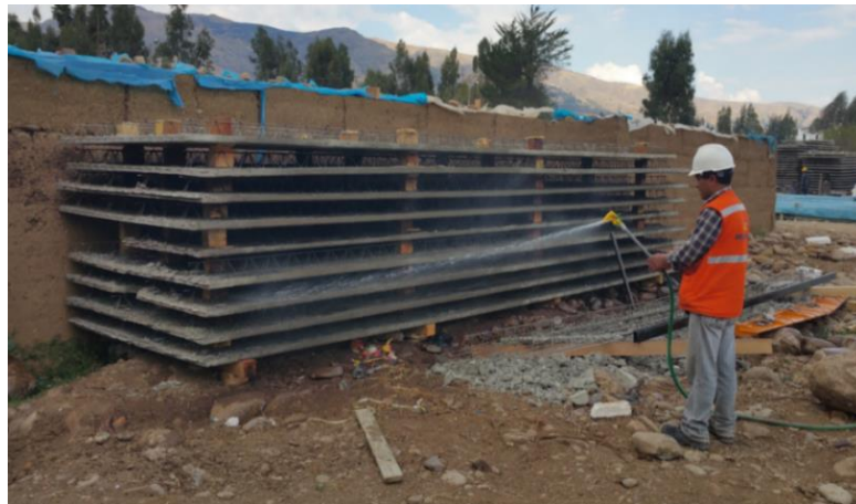
Figura 12: Curado de prelosa
