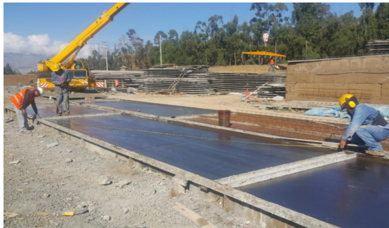
Figura 6: Trazo y encofrado de la prelosa
