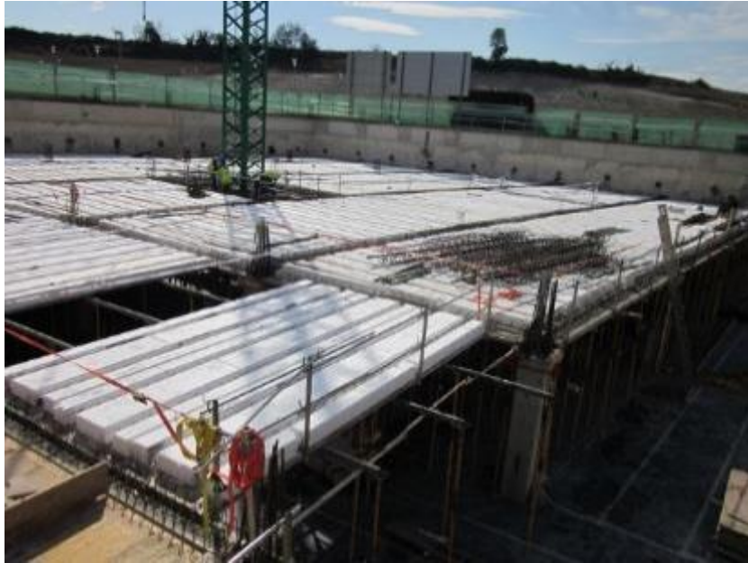
Figura 43: Prelosa con casetones de poliestireno
