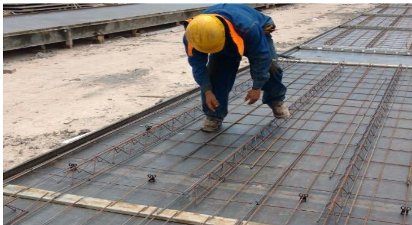
Figura 8: Colocación de separadores
