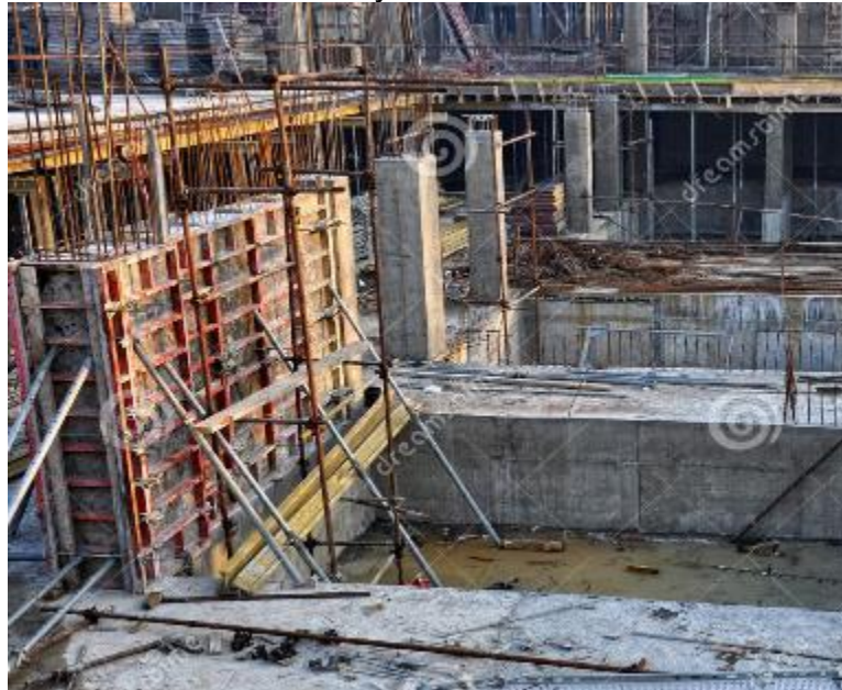
Figura 27: Encofrado y llenado de verticales
