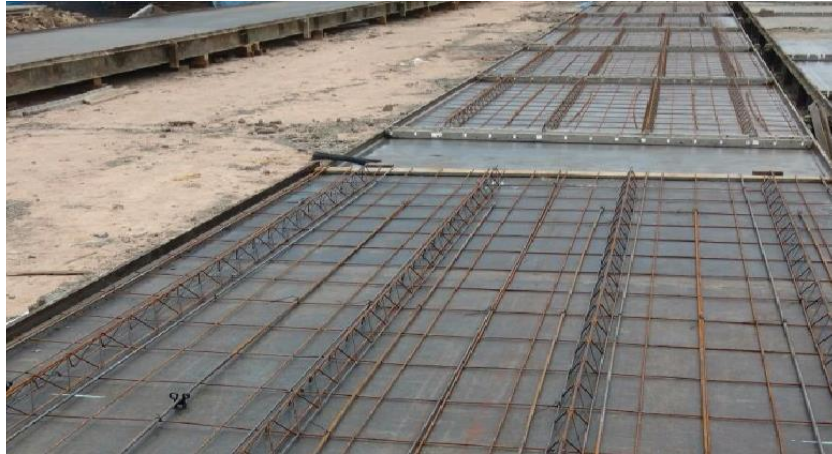
Figura 7: Instalación del acero
