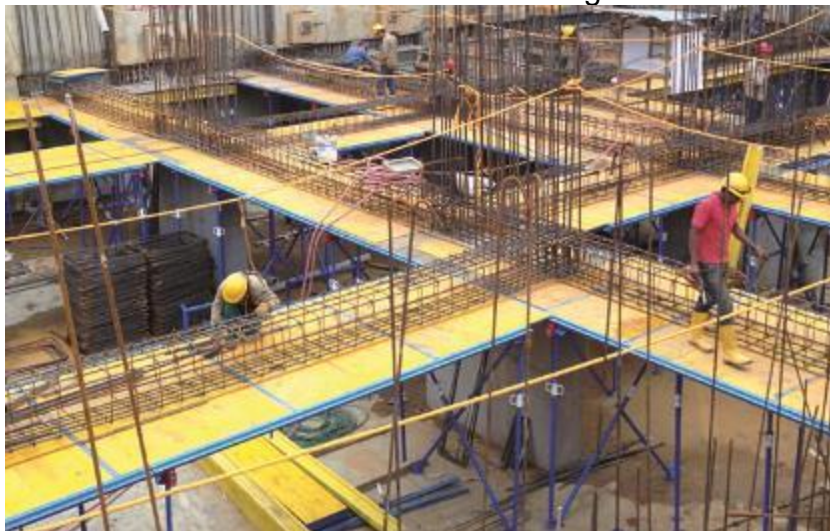
Figura 29: Colocación de Aceros de Vigas
