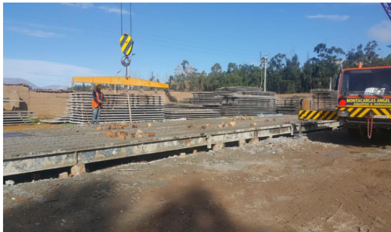
Figura 10: Desmoldaje de prelosa
