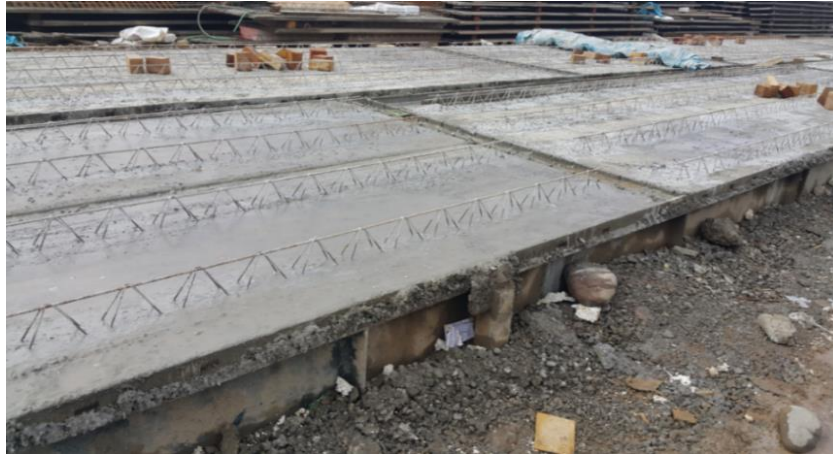
Figura 9: Vaciado de prelosa
