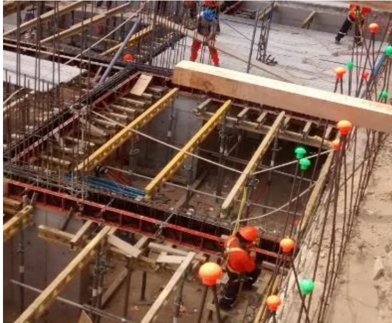
Figura 28: Encofrado de fondo y apuntalamiento prelosas
