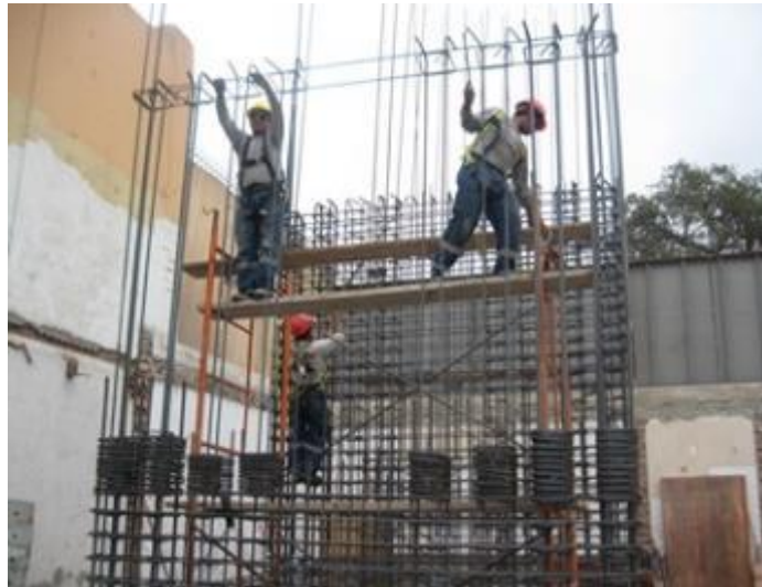
Figura 26: Colocación de Aceros Verticales
