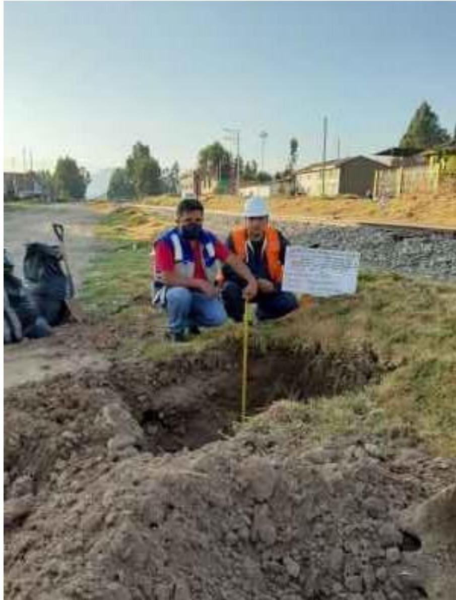
Fotografía 1: Extracción de muestras de suelo de la calicata C-1 progresiva KM 5+900
