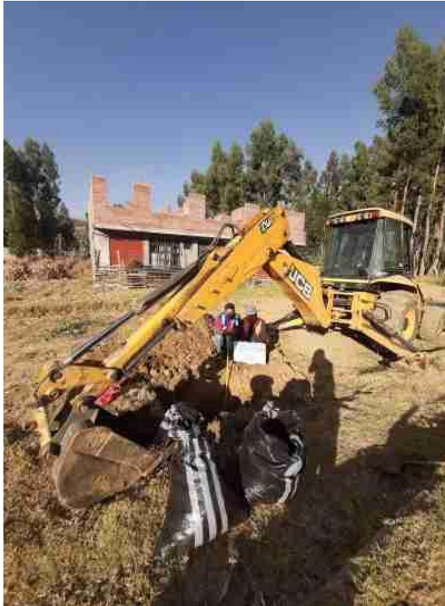
Fotografía 2: Extracción de la muestra de suelo de la calicata C-2 progresiva KM 6+400
