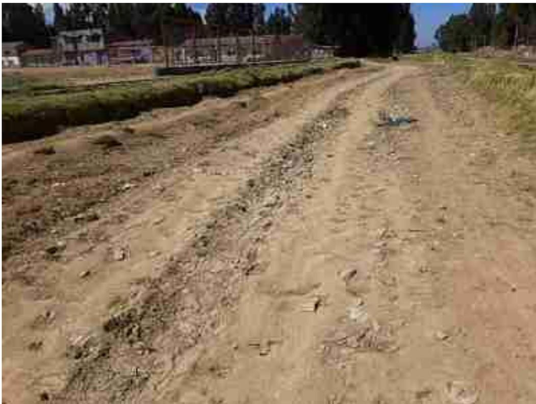
*Figura 1:* Subrasante Blando en mal estado con hundimientos Distrito Cajas.
