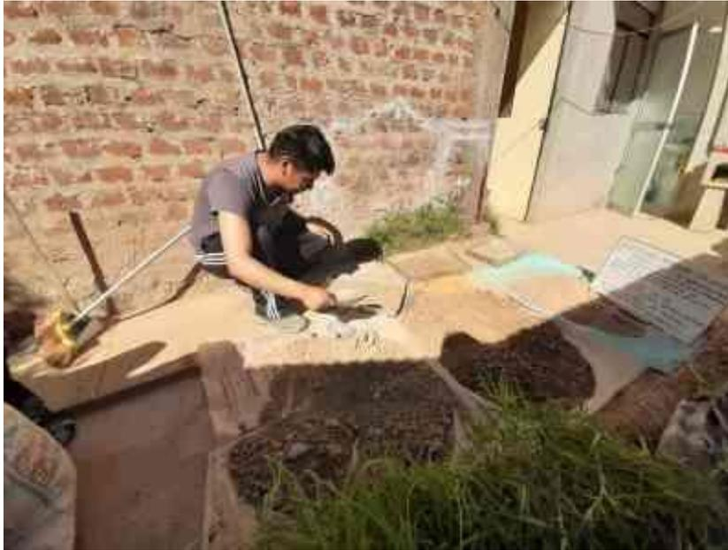
Fotografía 6: Secado de las calicatas C-1, C-2, C-3 progresivas
