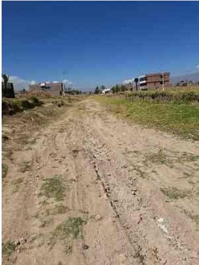
*Figura 2:* Subrasante blando con presencia de arcillas Distrito Cajas.
