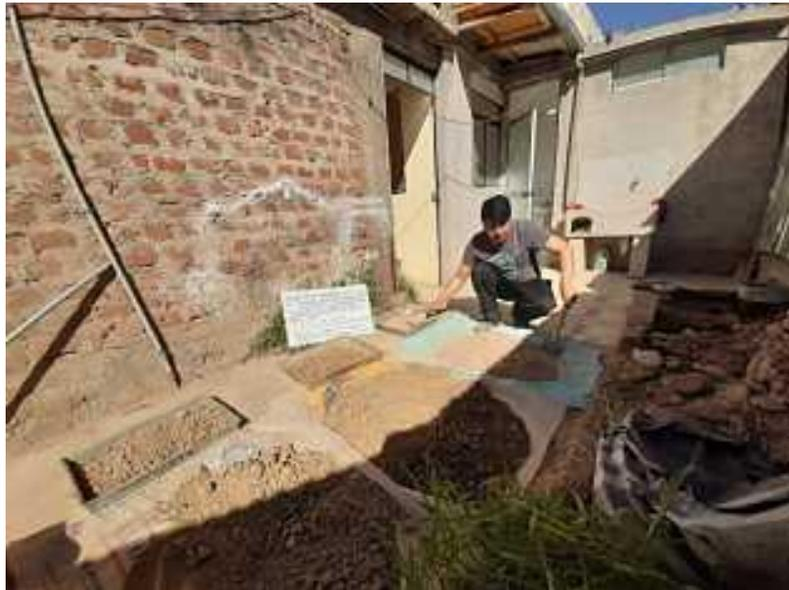
*Figura 20: Secado de material de las calicatas C-1, C-2 y C-3*
