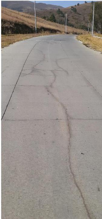
**Figura 2:** Deterioro del pavimento
