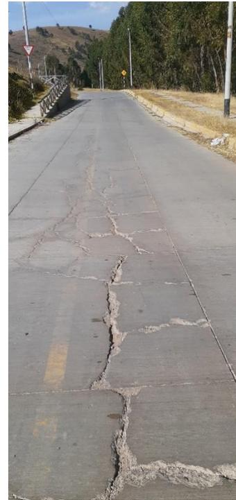
**Figura 3:** Deterioro del pavimento
