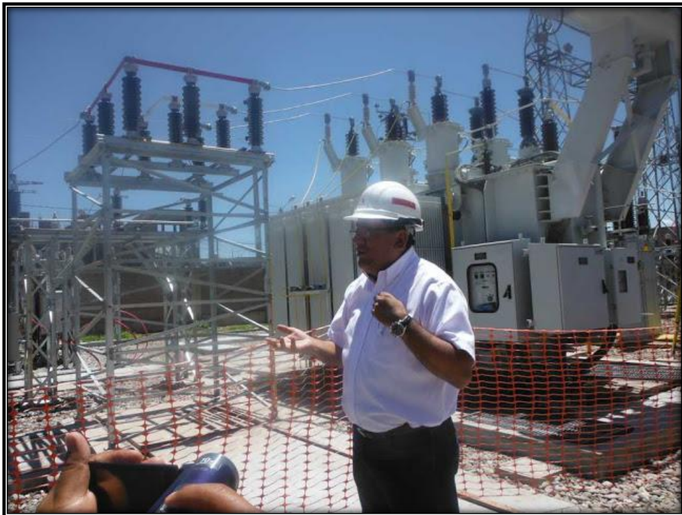
Foto N° 02: Charla de 5 minutos para inicio de actividades en obra
