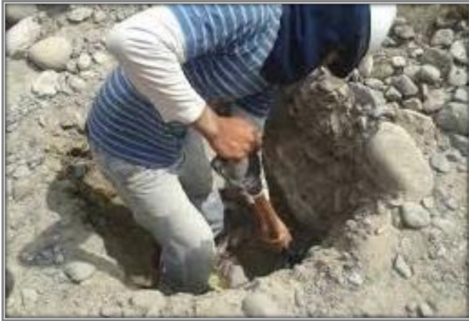
Foto N° 11: Calicata para el Estudio de Mecánica de Suelos
