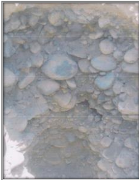
Foto N° 12: Estratigrafía de la calicata
