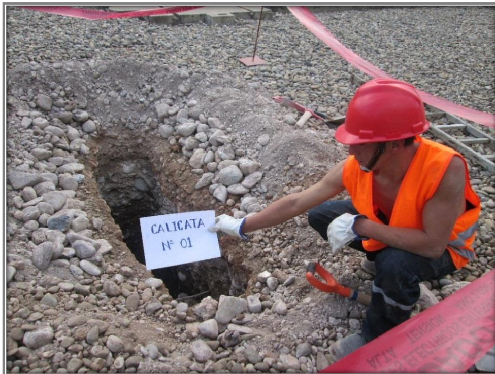
Foto N° 09: Calicata para el Estudio de Mecánica de Suelos
