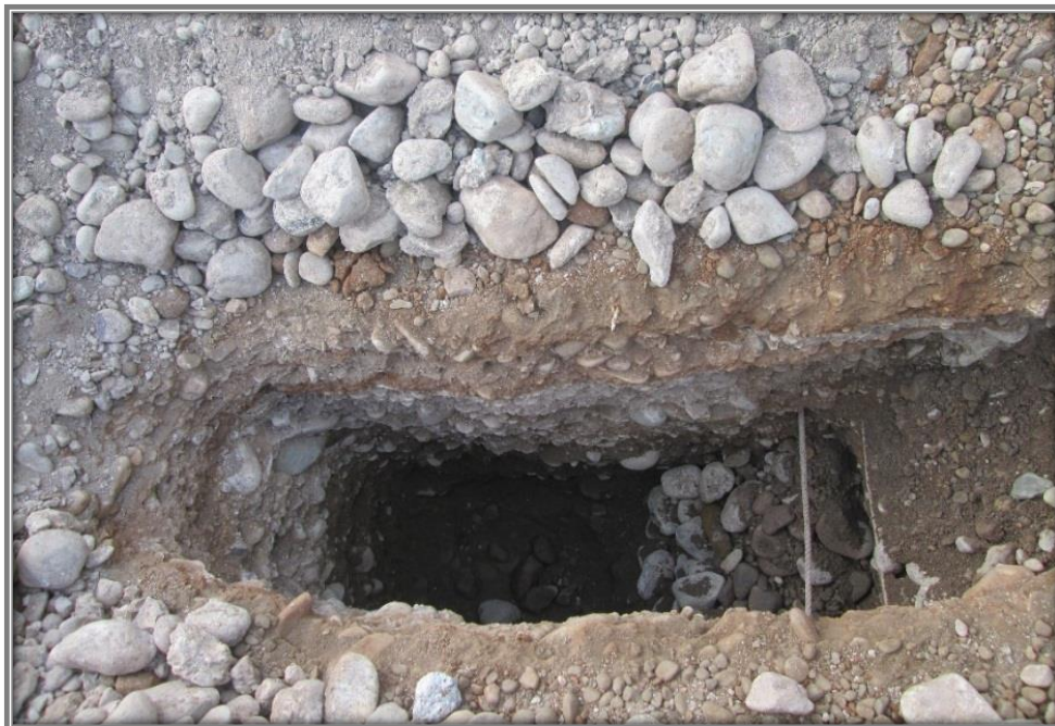
Foto N° 10: Calicata para el Estudio de Mecánica de Suelos
