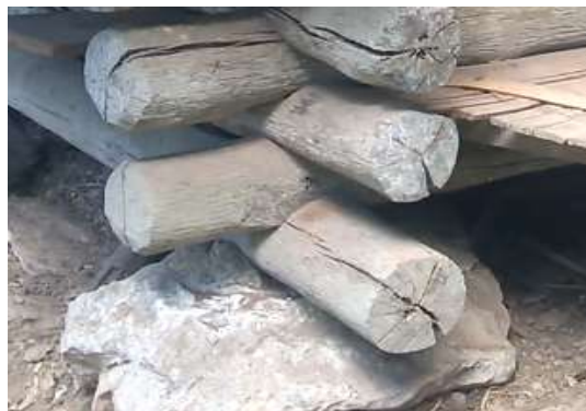
Gambar 3. (Pondasi) Batu Peradangan Sumber: Dokumentasi, 2017
