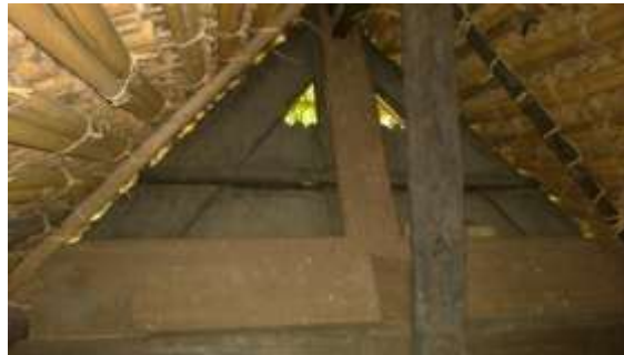
Gambar 7. Dinding segitiga ( para ) Sumber : Dokumentasi, 2017
