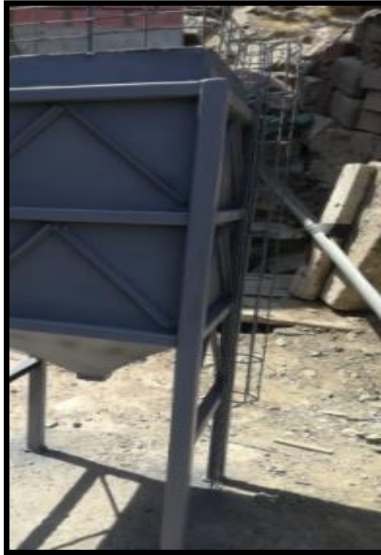
Figura 25. Estructura de tolva con barandas y escalera
