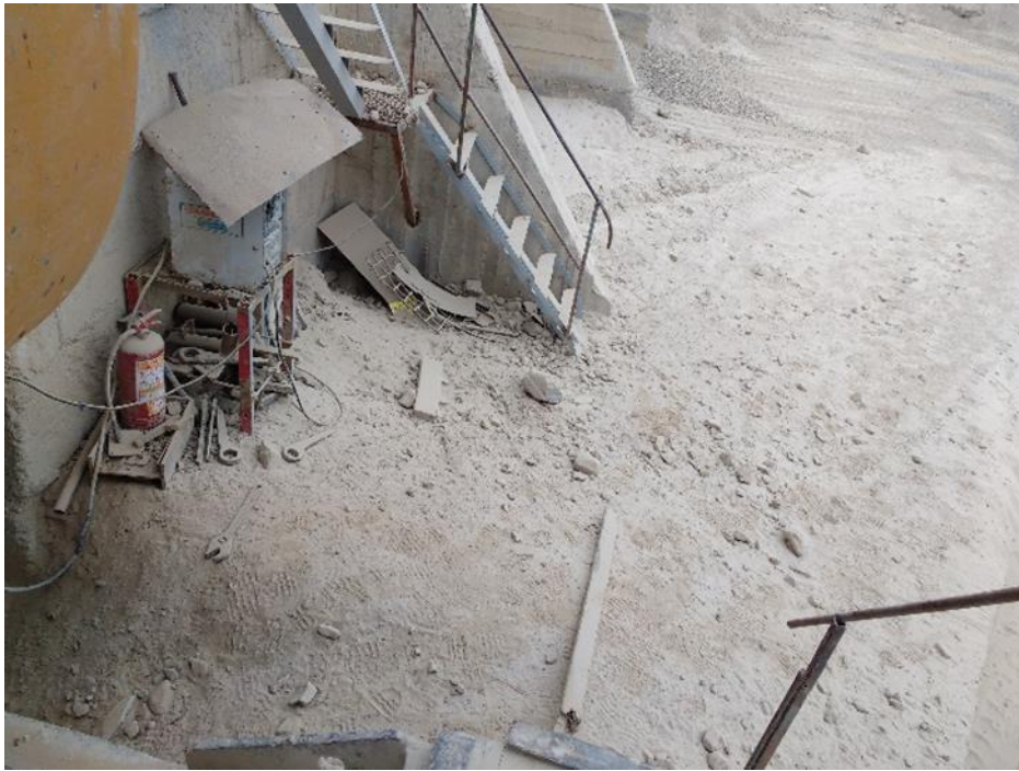
Figura 37 Polvo sedimentado en las instalaciones
