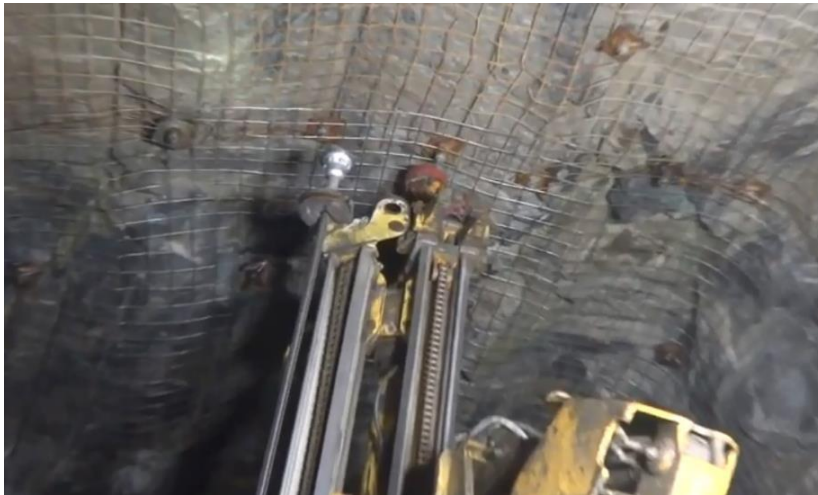
Figura 4. Mallas electrosoldadas; Instalación de mallas electrosoldadas. Fuente: Fuerza Minera.
